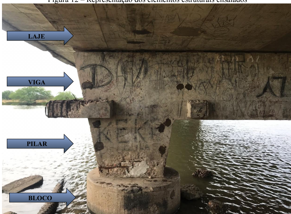
Figura 12 – Representação dos elementos estruturais ensaiados
