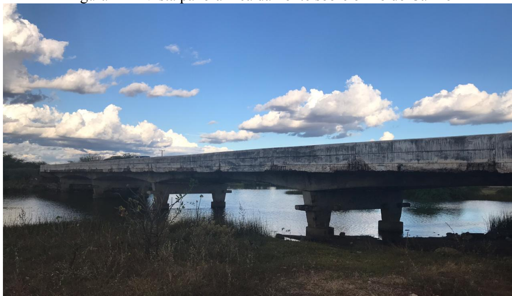
Figura 11 – Vista panorâmica da Ponte sobre o Rio do Carmo
