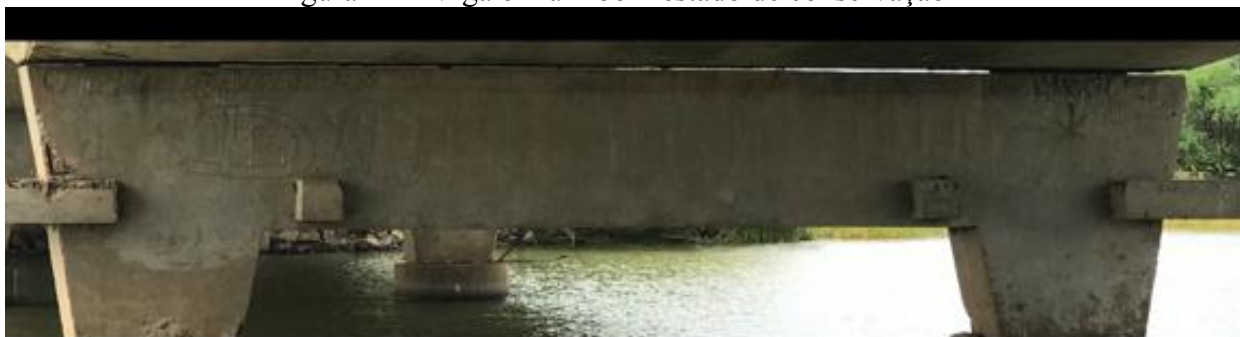
Figura 22 – Viga em um bom estado de conservação
