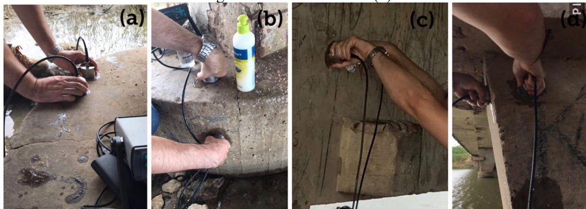
Figura 14 – Medição indireta do bloco de coroamento (a); medição semi-direta do bloco de coroamento (b); medição indireta da viga de contraventamento (c) e medição semi-direta da viga de contraventamento (d)
