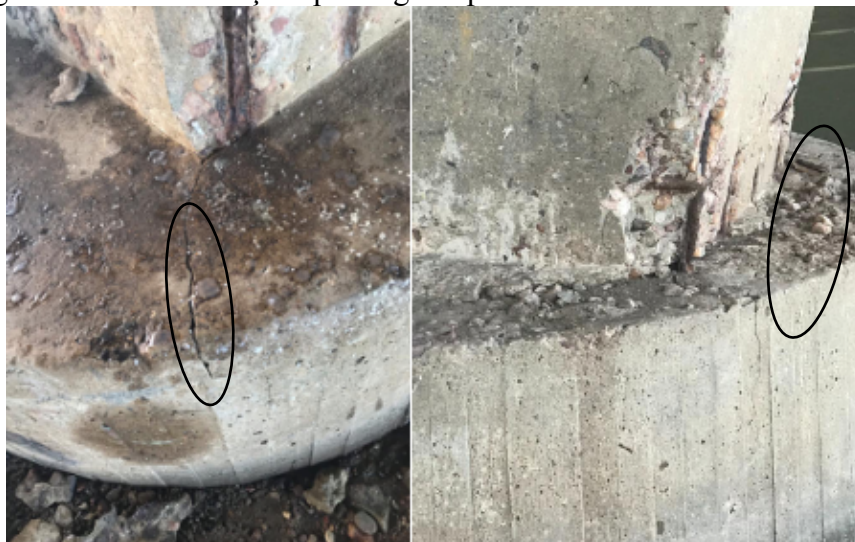
Figura 20 – Manifestações patológicas presentes no bloco de coroamento
