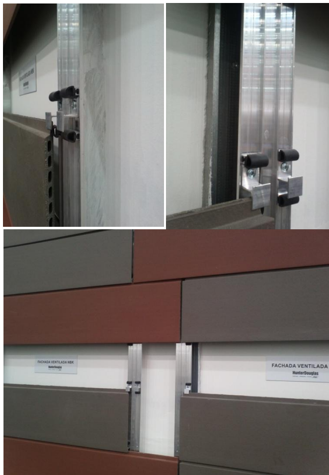
Figura 3 – Detalhe da estrutura linear na fachada ventilada
