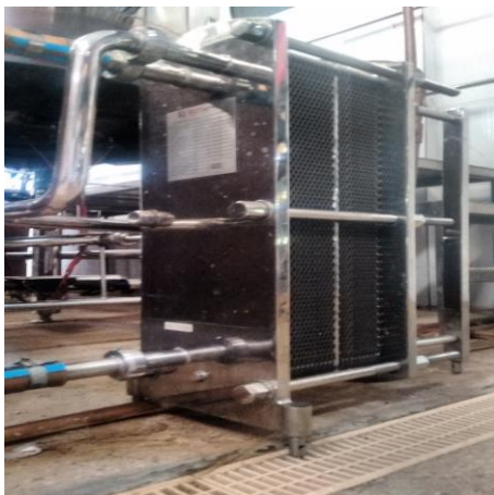
Figura 4: trocador de calor de placas
