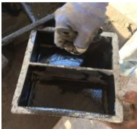
Figura 15 - Lubrificação das formas com óleo diesel.
