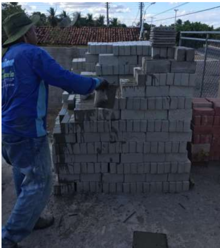
Figura 22 - Colaborado lançando água sobre os blocos
