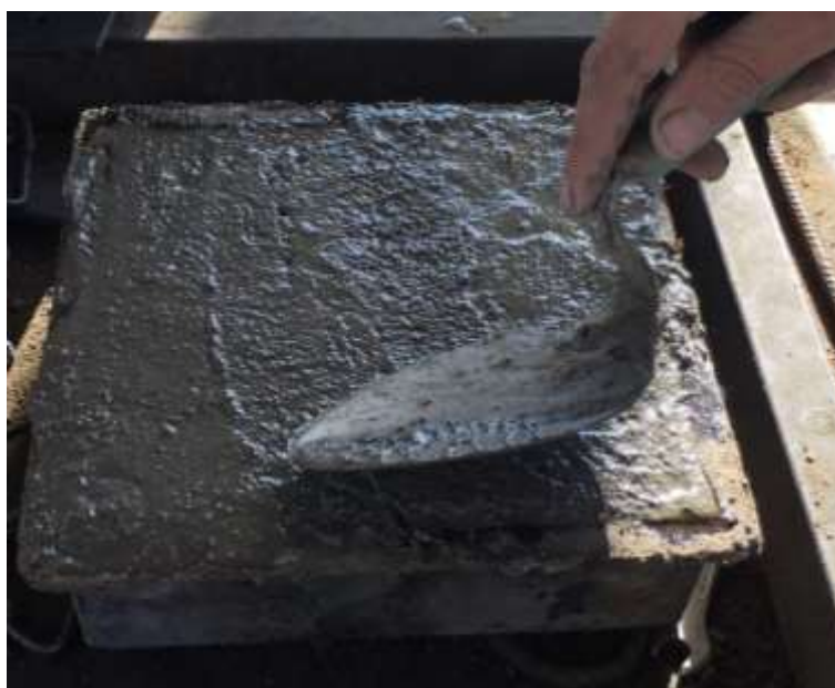
Figura 19 - Retirada do excesso de concreto.
