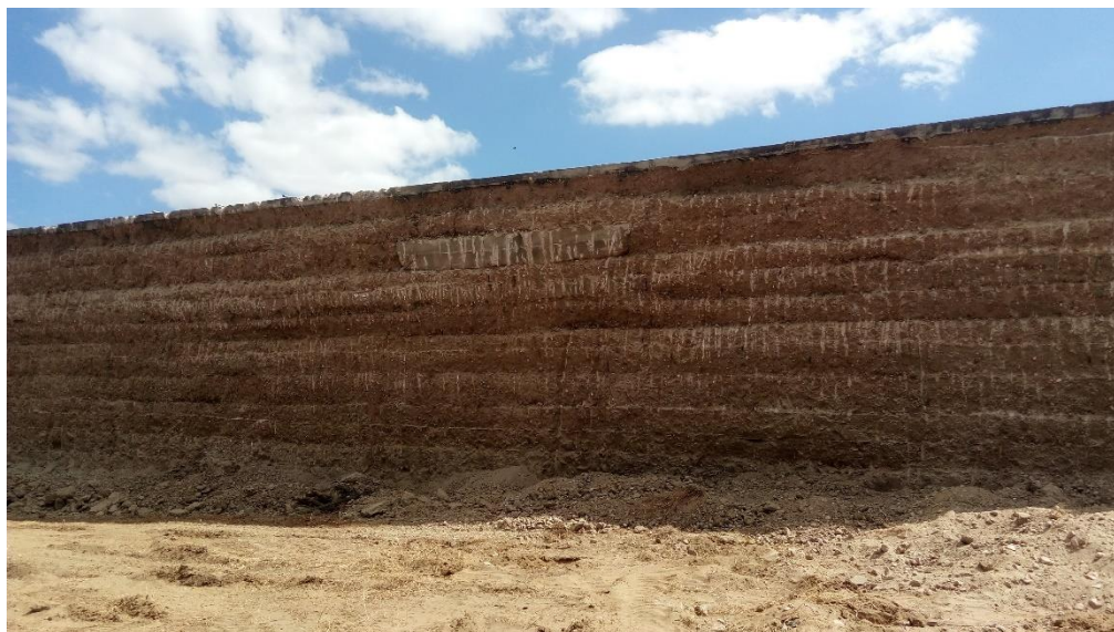
Figura 28- Paramento de jusante escarificado.
