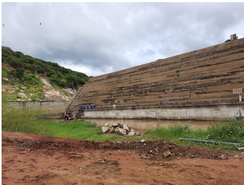
Figura 43 - Envelopamento dos degraus do vertedouro.
