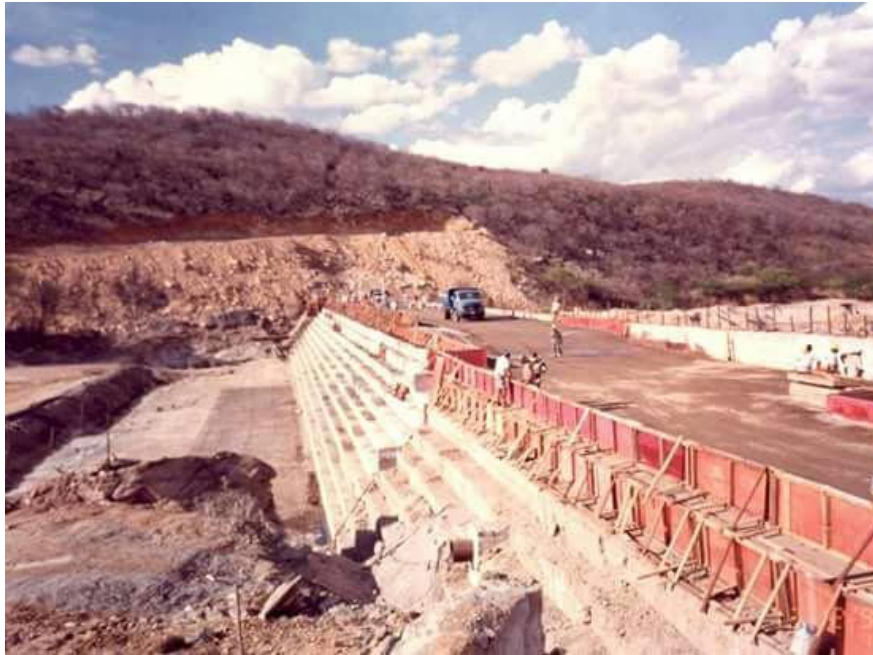
Figura 33 - Construção do barramento da barragem Passagem das Traíras.
