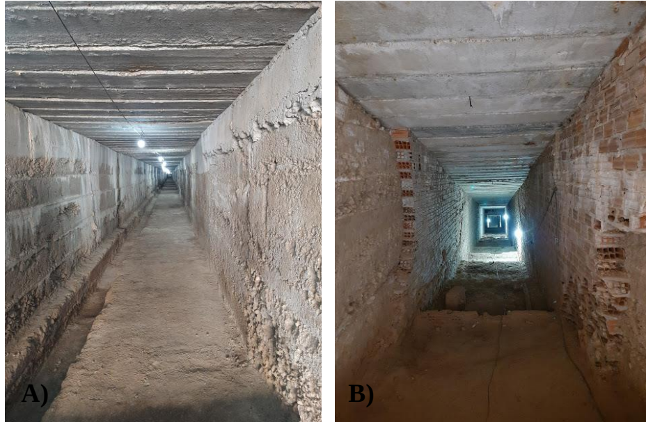
Figura 18- A) Galeria saída do vertedouro e B) entrada pela ombreira esquerda.
