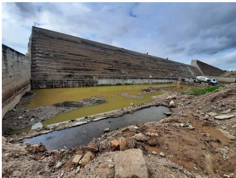
Figura 24- Bacia de dissipação.
