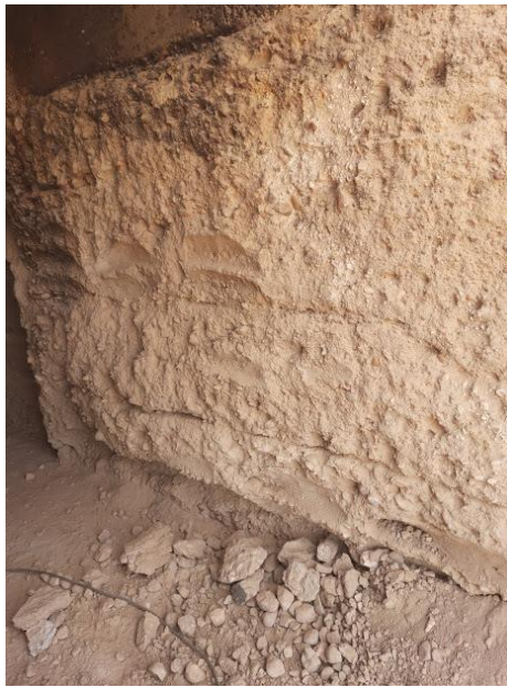
Figura 29- Parede interna da galeria, que era revestida de alvenaria.
