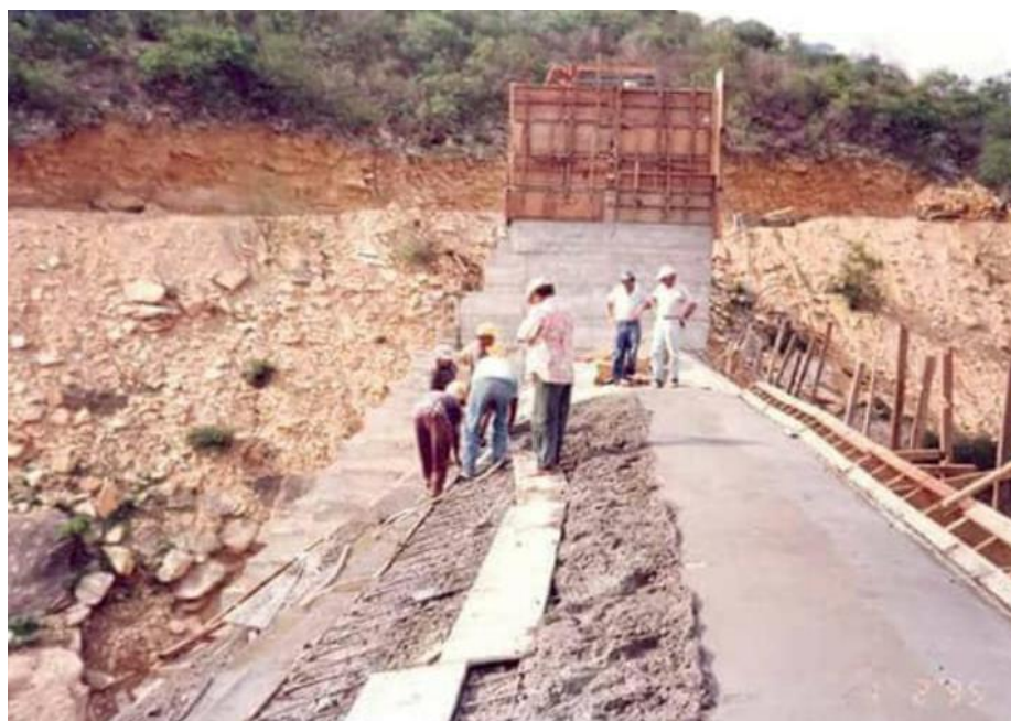
Figura 36 - Finalização do vertedouro.
