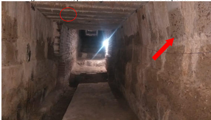
Figura 17- Galeria, parte entre vertedouro e ombreira esquerda.
