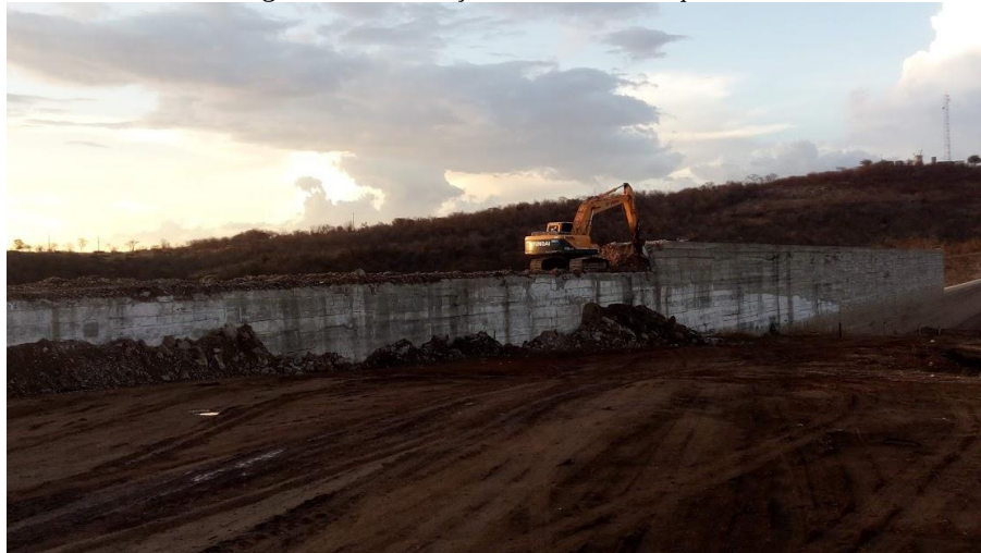
Figura 39- Demolição da ombreira esquerda.
