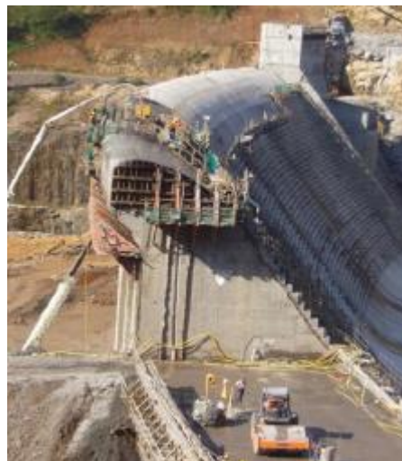
Figura 4 - Barragem em arco-gravidade em construção.
