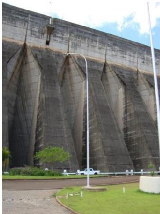
Figura 2 - Barragem em contraforte
