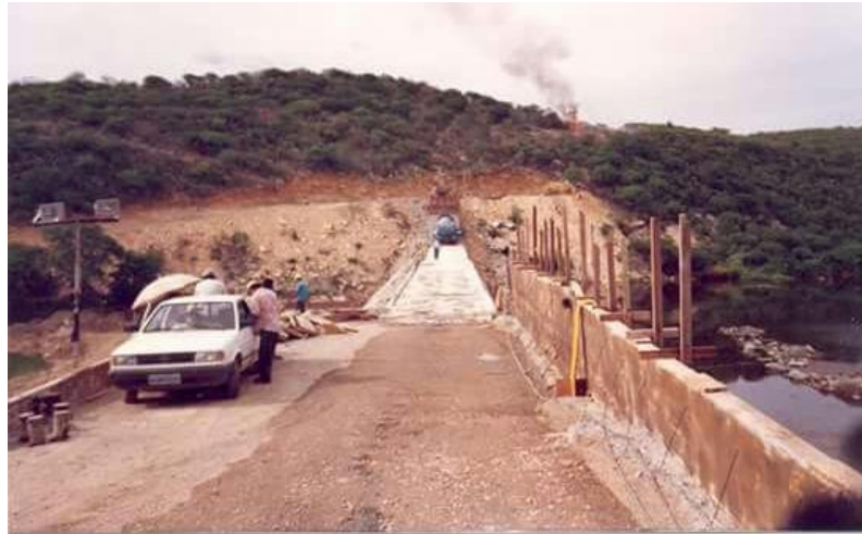
Figura 35 - Concretagem da barragem Passagem das Traíras.
