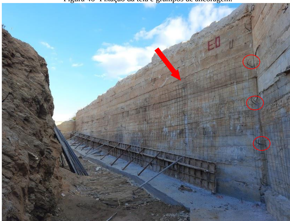
Figura 46- Fixação da tela e grampos de ancoragem.
