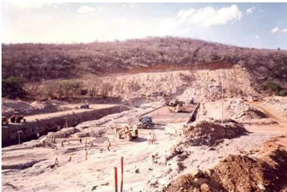
Figura 32- Barragem Passagem das Traíras, em fase de construção.
