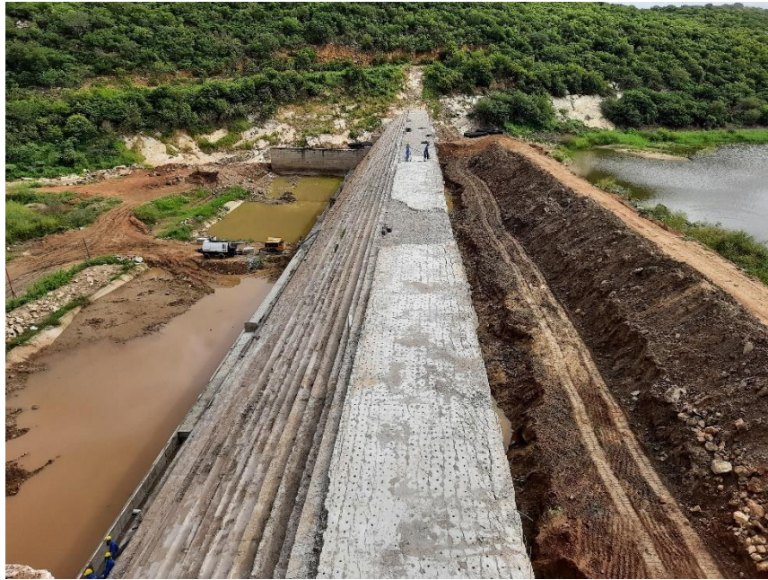
Figura 41- Demolição da crista do perfil creager do vertedouro.
