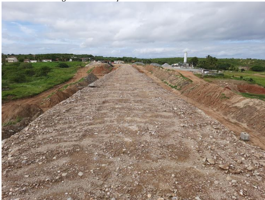
Figura 40- Demolição de 2 m de CCR concluída.
