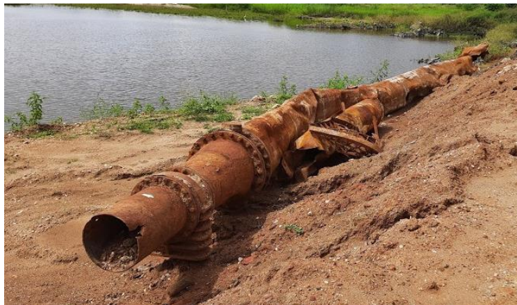
Figura 26- Descarga de fundo retirada.
