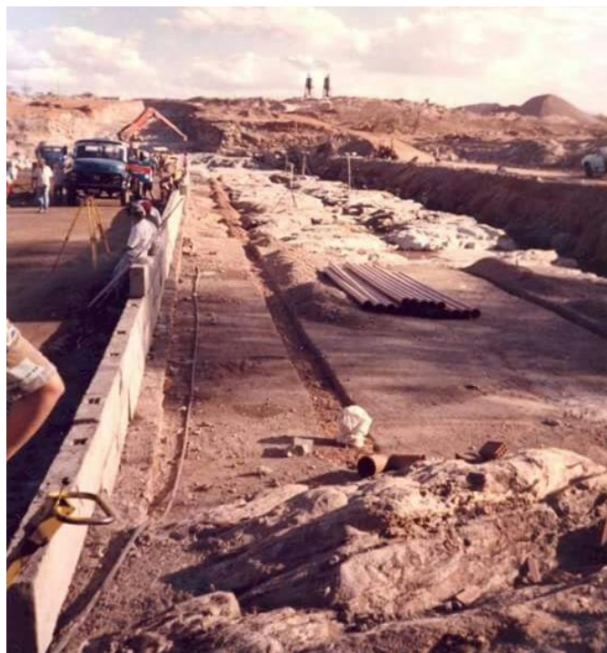
Figura 34- Construção do vertedouro da barragem Passagem das Traíras.
