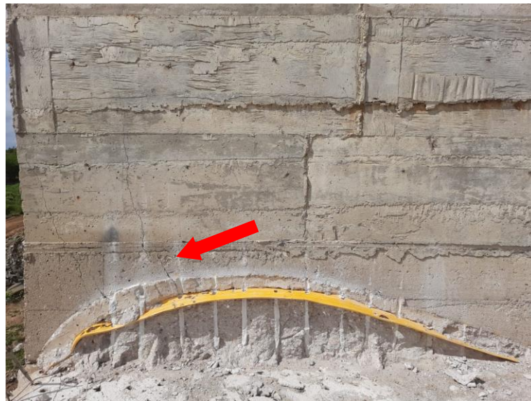
Figura 23 - Ligação do vertedouro com a ombreira esquerda.
