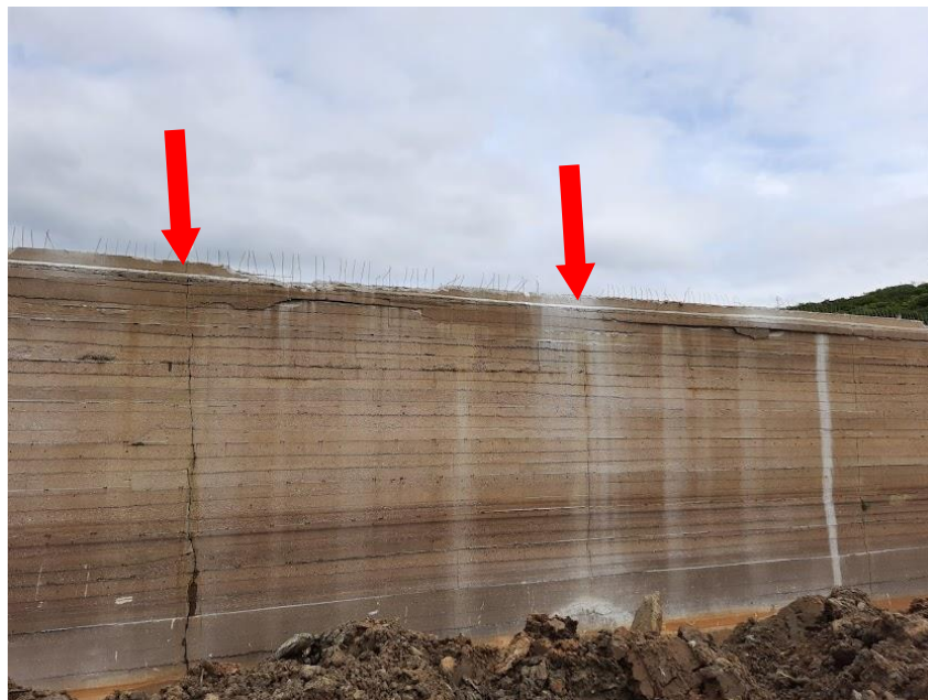
Figura 12- Paramento de montante, área do vertedouro.
