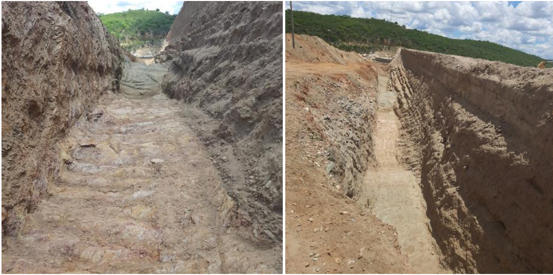
Figura 16- Fundação do paramento jusante.
