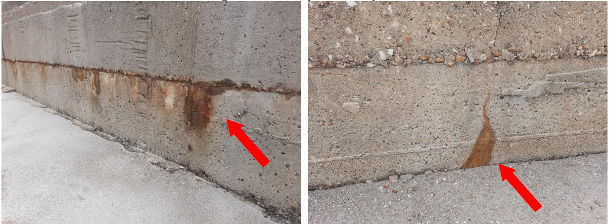
Figura 22- Infiltração e lixiviação.
