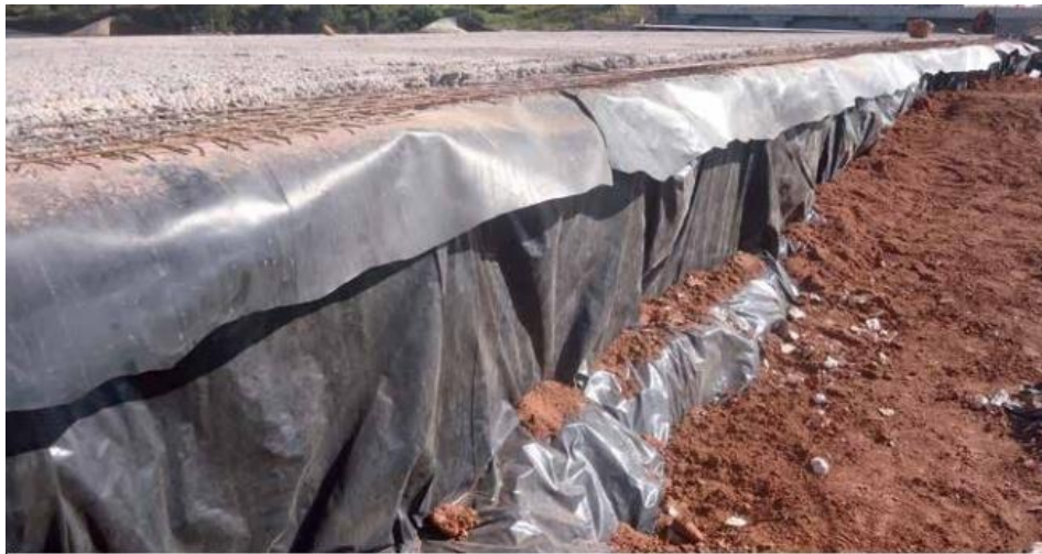
Figura 2. 2: Utilização da geomembrana como proteção em aterro
