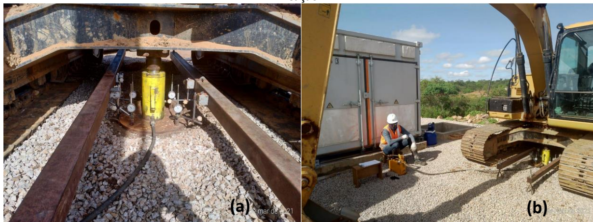
Figura 12 - Detalhe da montagem das PCP: (a) montagem da PCP (b) Escavadeira hidráulica utilizada como reação
