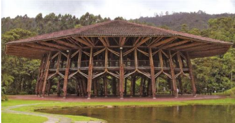
Figura 05: Pavilhão de bambu.
