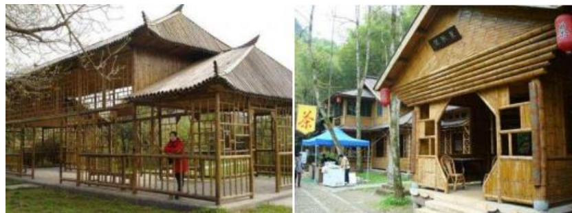
Figura 04: Estruturas e paredes de bambu.
