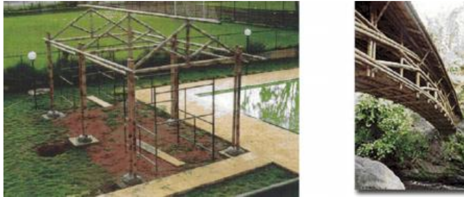
Figura 03: Treliça de bambu para sustentação do telhado/ Ponte treliçada em bambu.
