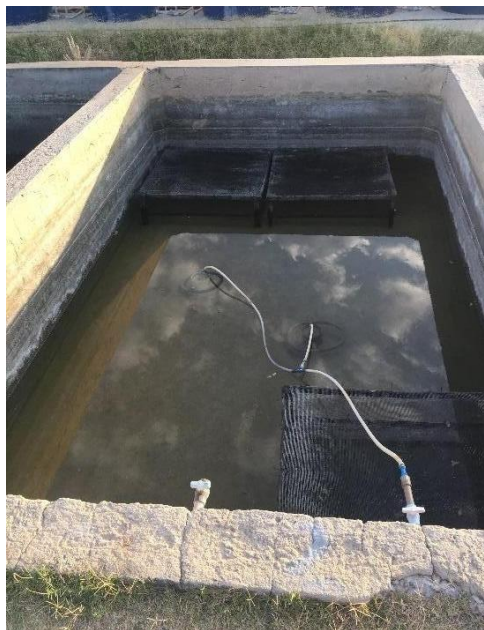
Figura 4: Tanques de alvenaria localizadas no Setor de Aquicultura da Ufersa, utilizados no estudo. Fonte: Imagem do autor.
