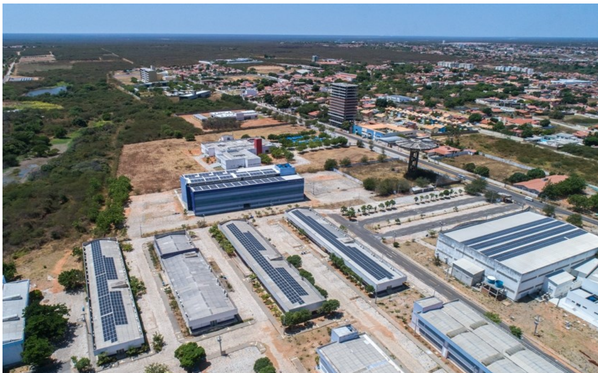
Figura 14 – Vista aérea das usinas solares do campus de Mossoró.
