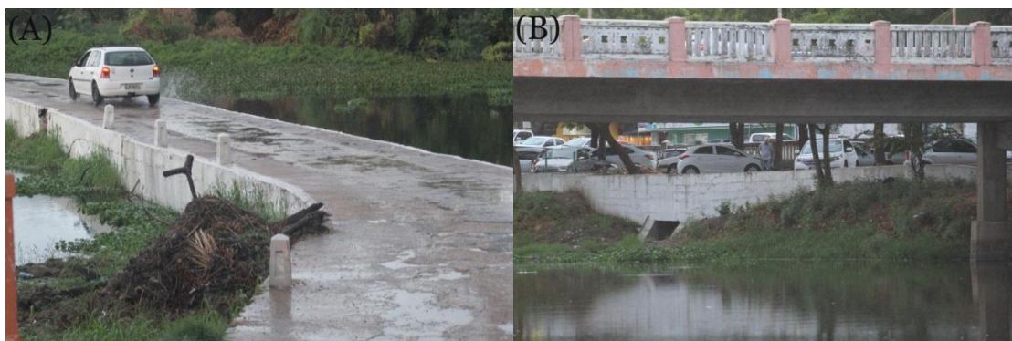
Figura 4. Retirada da mata ciliar para a construção de pontes. Fonte: Autoria própria (2020)
