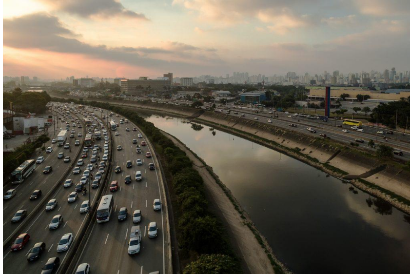
Figura 1: Pista expressa da Marginal Tietê em São Paulo
