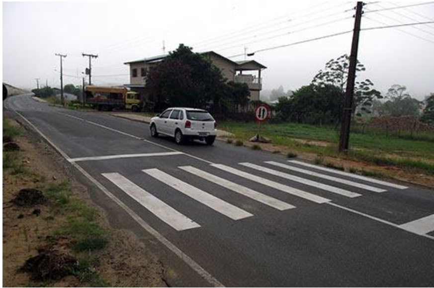
Figura 10: Sinalização Horizontal BR-101 Sul/SC
