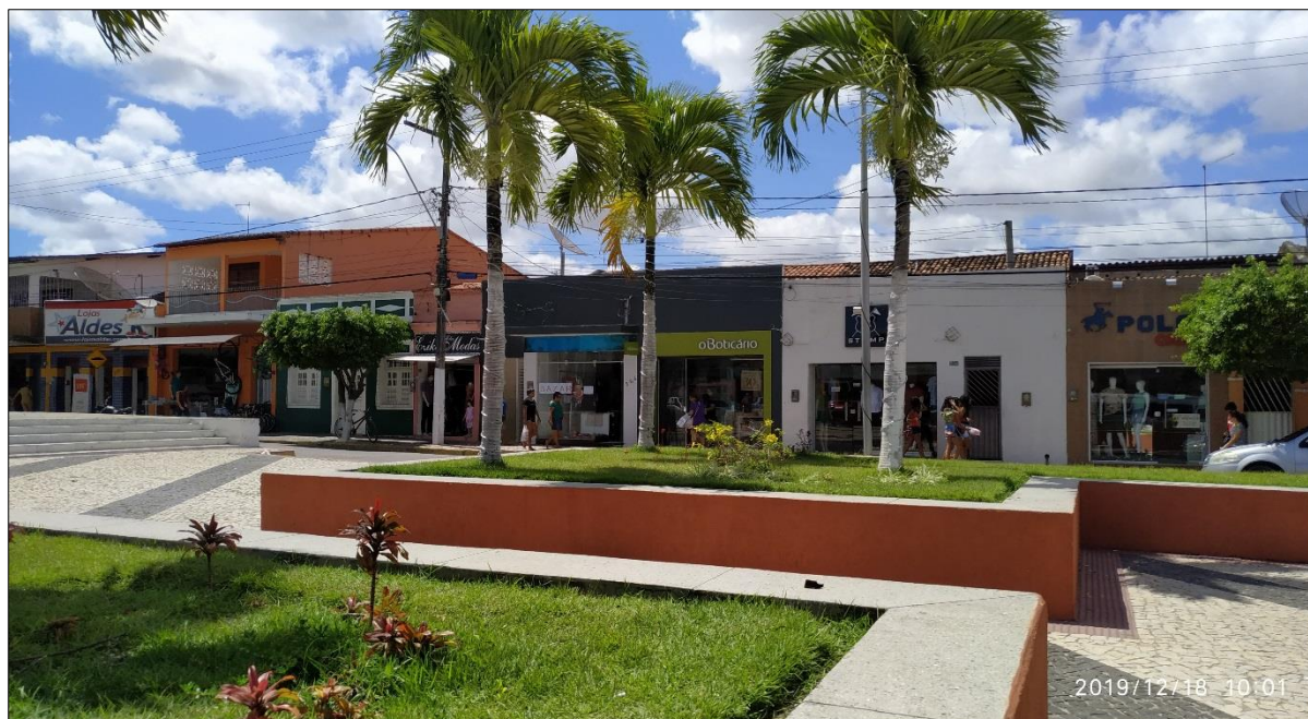
Figura 3 – Vista de parte dos empreendimentos da Rua Doutor João Primênio
