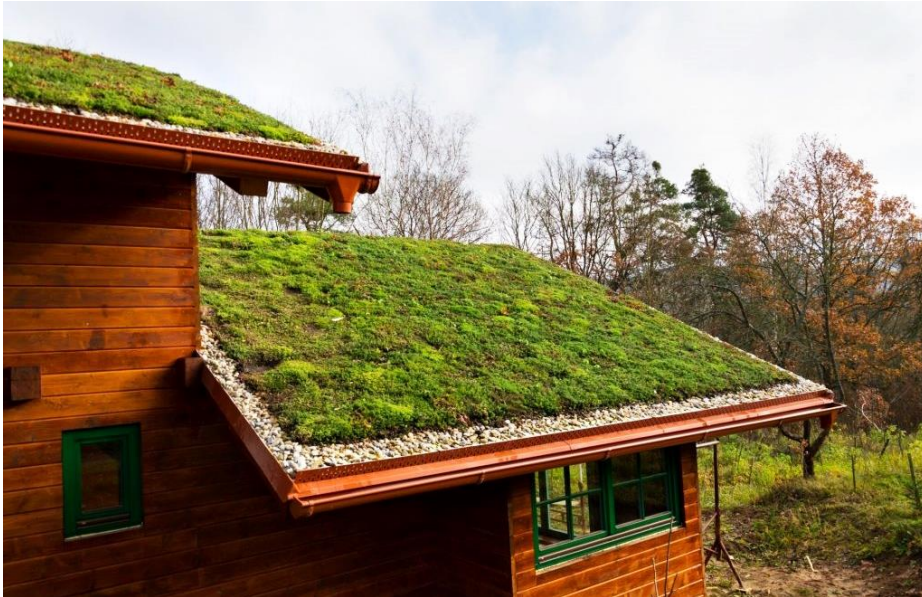
Figura 9 – Telhado verde residencial
