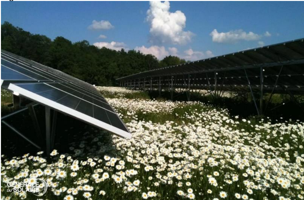
Figura 16 – Usina solar instalada em solo sobre uma camada verde
