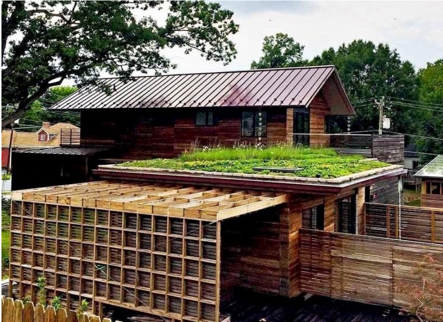
Figura 10 – Telhado verde parcial
