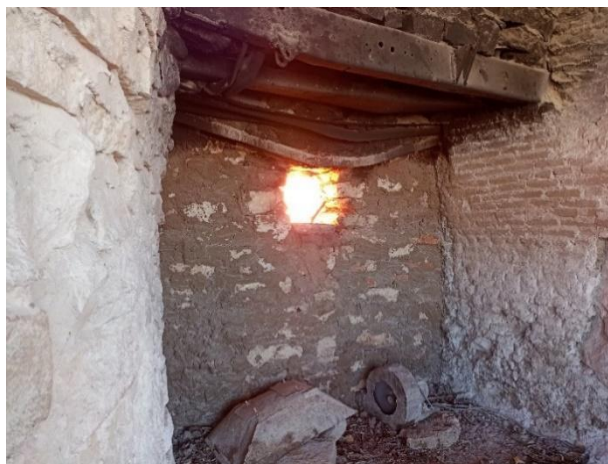
Figura 3 - Estrutura de um forno para queima de calcário.
