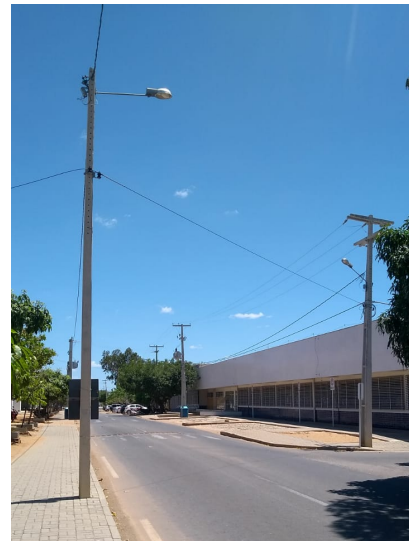
FIGURA 9. PARTE DE UMA DAS VIAS DE TRÁFEGO DA UFERSA.
