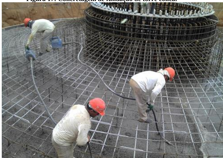
Figura 17: Concretagem de fundação de torre eólica.
