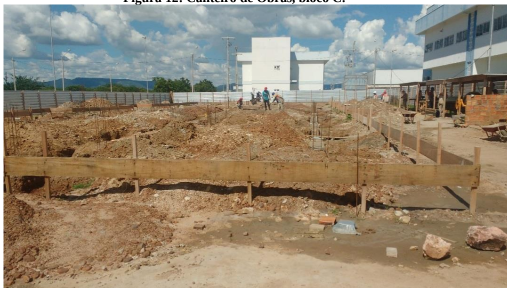
Figura 12: Canteiro de Obras, bloco C.
