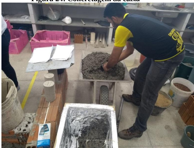
Figura 24: Concretagem da caixa
