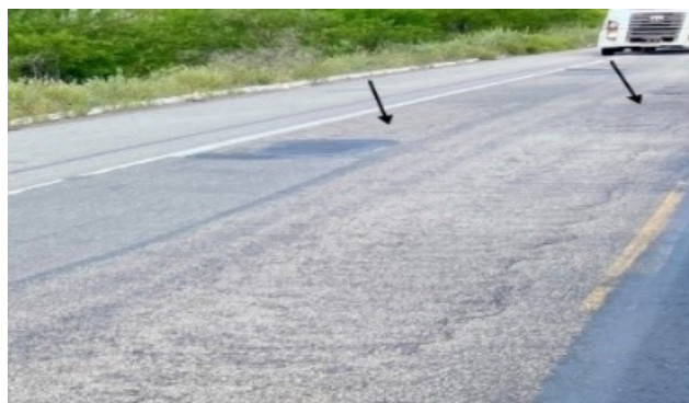
Figura 3 – Desgaste (D)
