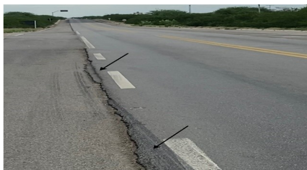
Figura 4 – Escorregamento de massa (E)
