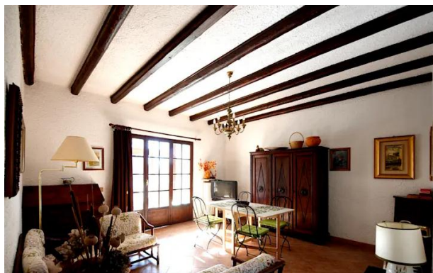
Figura 12 – Vigas de Madeira em Construções Rústicas
