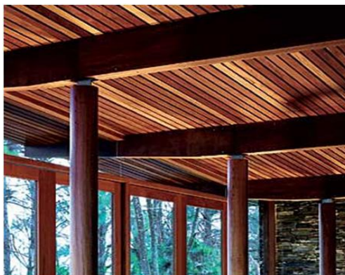
Figura 10 – Pilares de Madeira
