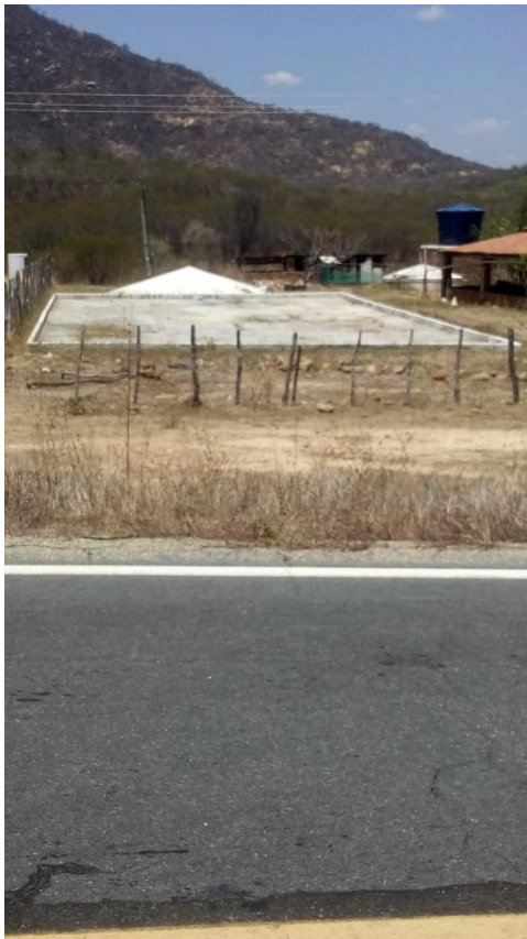
Figura 2 – Cisterna de Calçada
