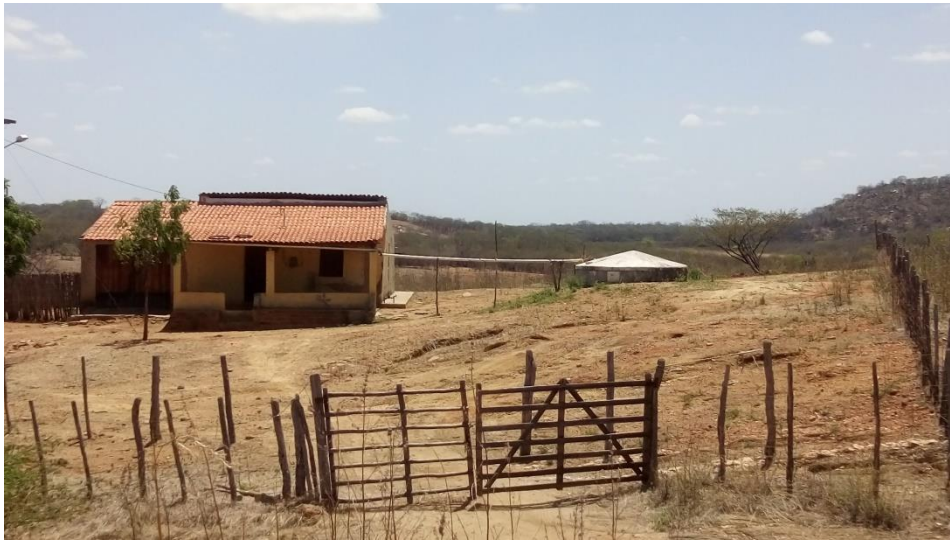
Figura 1 – Cisterna de Placa
