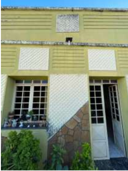
Figura 31 - Detalhes da fachada, residência n° 12
