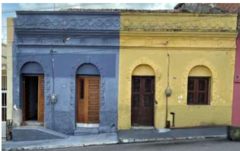
Figura 18 – Fachada casas iguais
