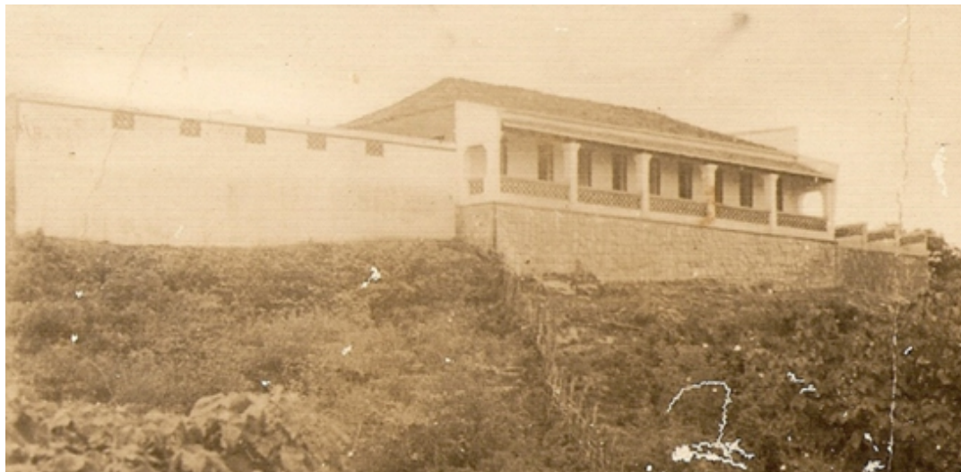
"Casa moderninha" na década de 1960
