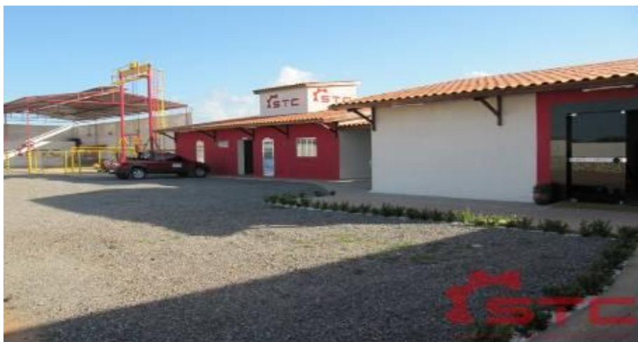
Figura 1: Empresa STC Inspeções e Testes de Equipamentos (Fonte: STC, 2014)
