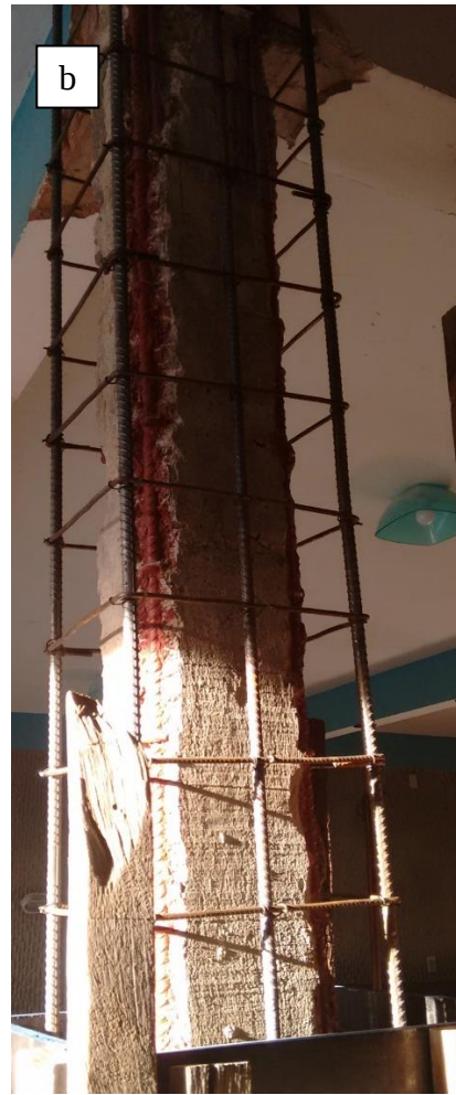
Figura 29 a e b: Pilares reforçados através do aumento da seção transversal da seção
