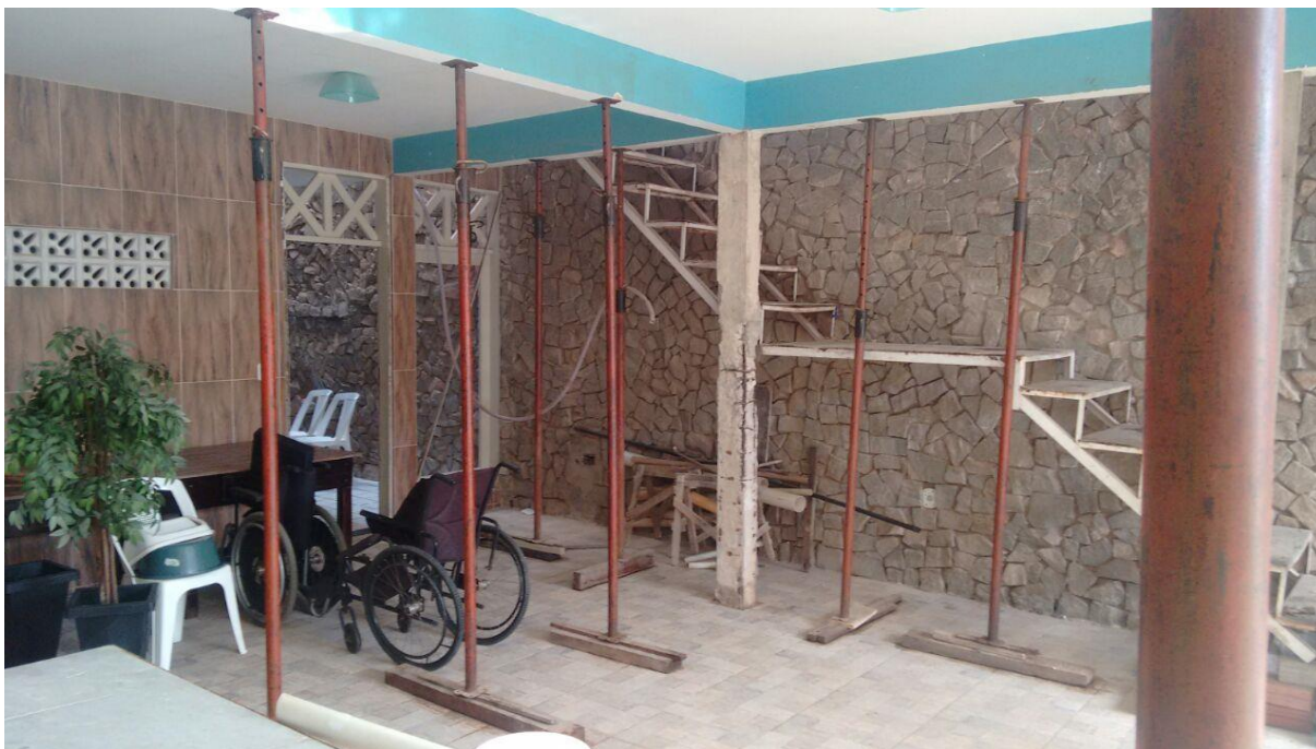
Figura 28: Escoramento da estrutura para reforço dos pilares;
