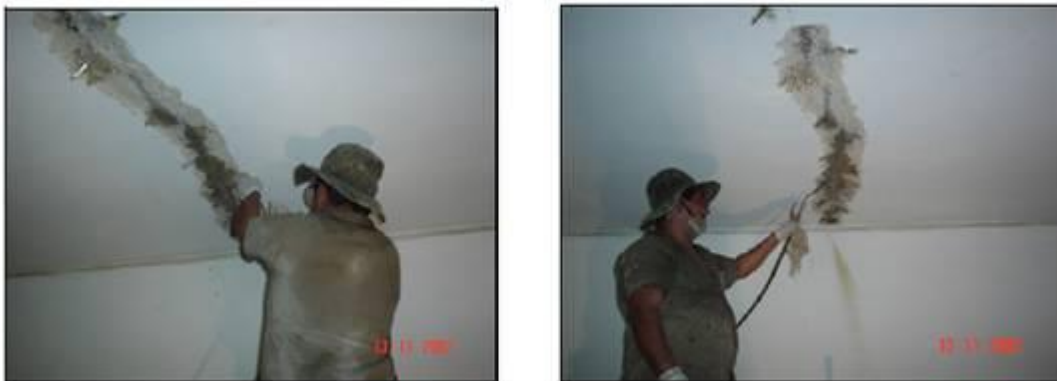
Figura 19: Processo de injeção de fissuras
