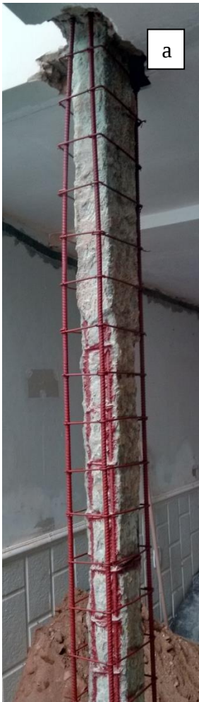
Figura 29 a e b: Pilares reforçados através do aumento da seção transversal da seção
