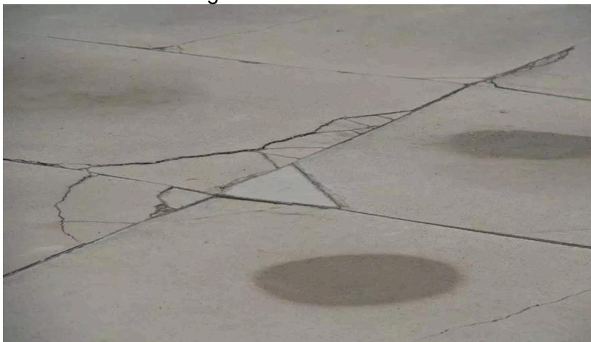
Figura 3 – Rachadura
