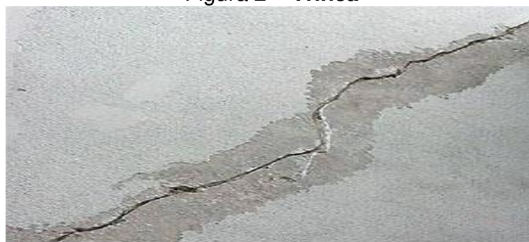
Figura 2 – Trinca
