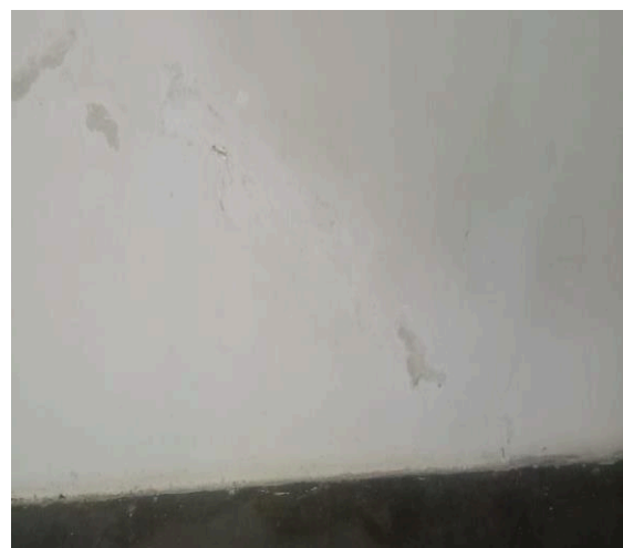
Figura 16 – Destacamento da pintura- (a) Muro; (b) Sala de Aula
