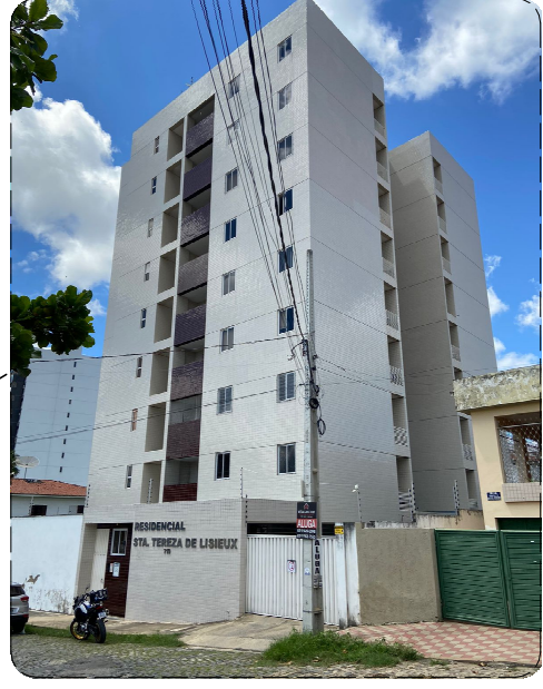
Residencial Sta. Tereza
