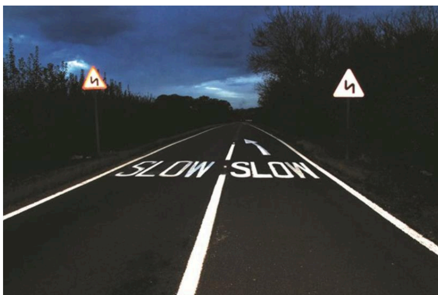
Figura 10 – Retro refletância em sinalização horizontal e vertical através de microesferas de vidro
