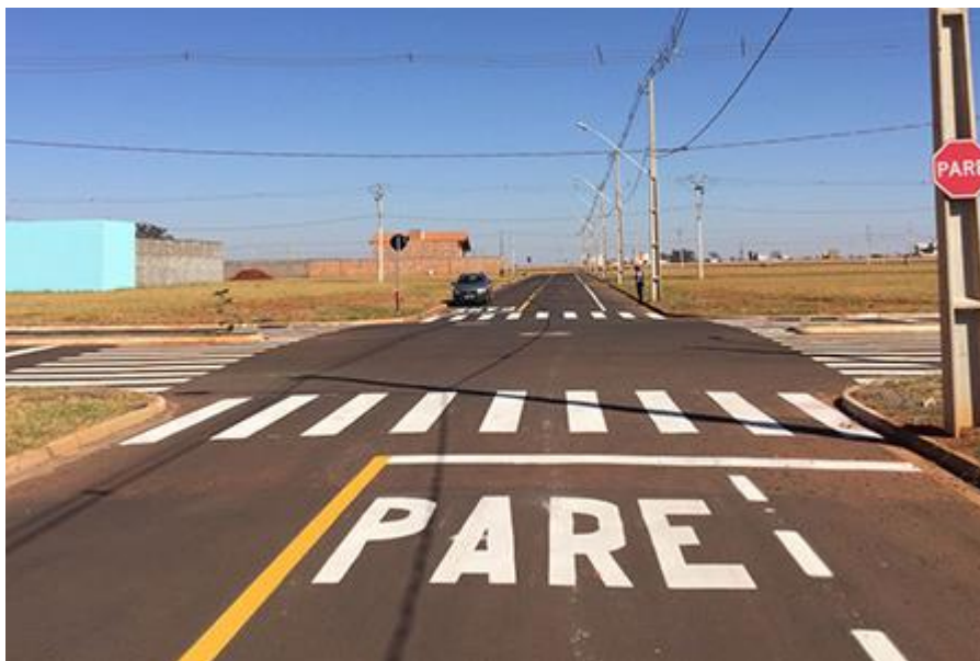
Figura 11 – Via com sinalização horizontal e vertical
