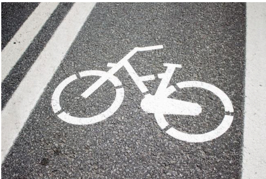
Figura 14 – Marca transversal sinalizando uma ciclovia
