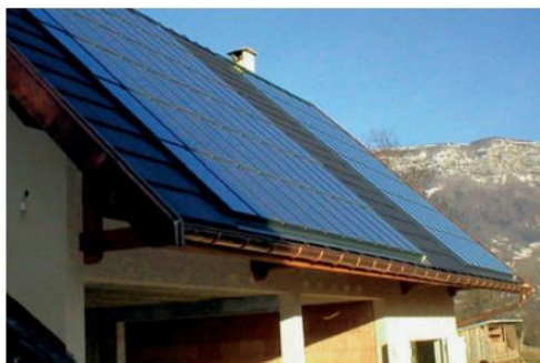
Figura 13: Sistema fotovoltaico distribuído conectado à rede elétrica.
