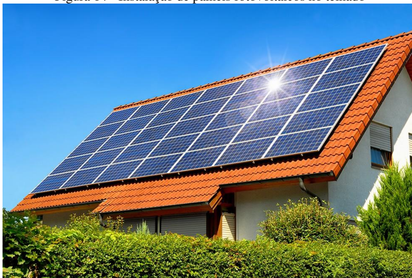
Figura 14 - Instalação de painéis fotovoltaicos no telhado
