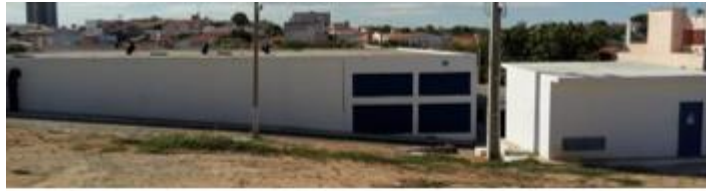
Figura 11 - Comandos e bombas
