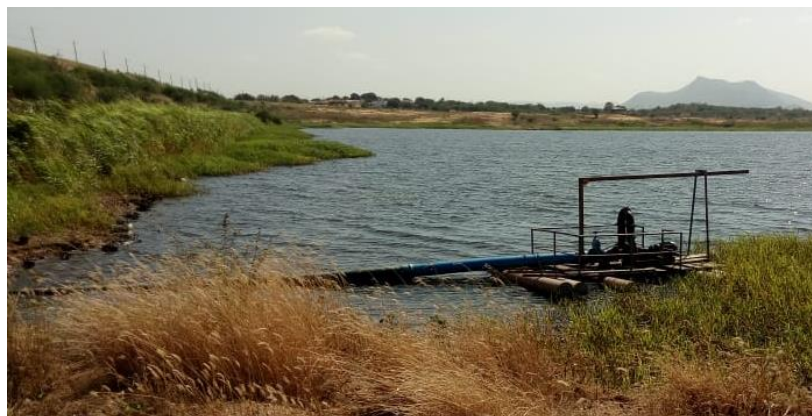
Figura 13 - Balsa flutuante, açude Itans
