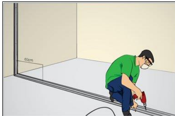
Figura 15 – Colocação das guias
