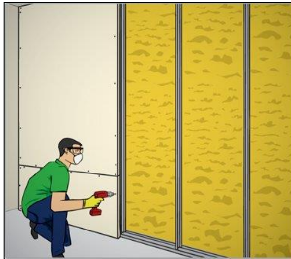
Figura 20 – Instalação das chapas do outro lado do montante
