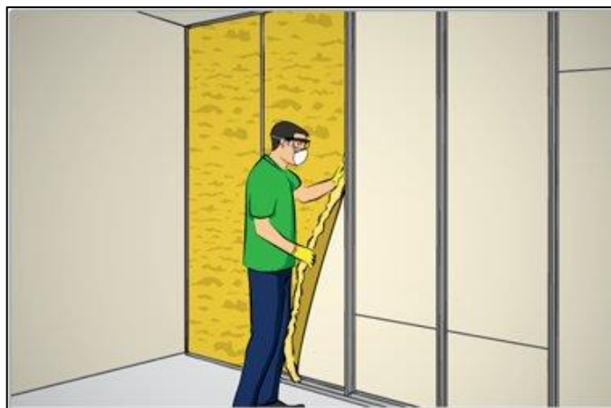
Figura 19 – Colocação das lãs minerais
