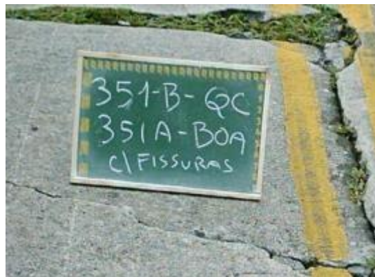
Figura 5: Ilustração da manifestação patológica Alçamento de Placa
