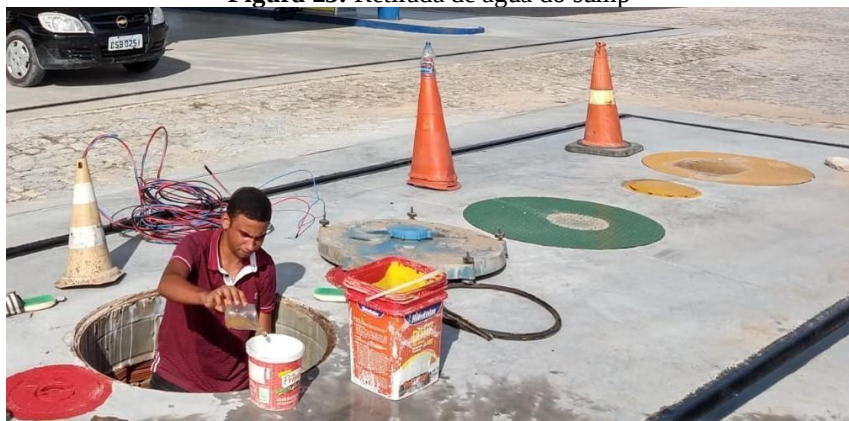
Figura 23: Retirada de água do sump
