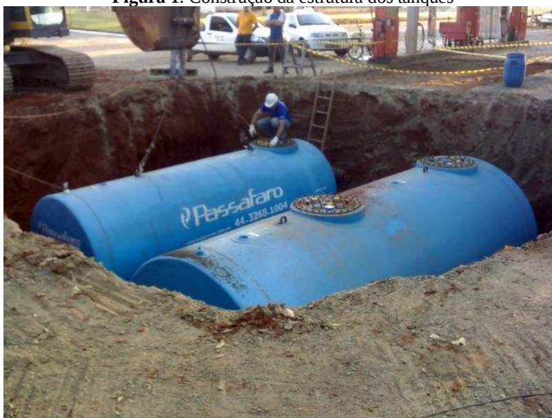
Figura 1: Construção da estrutura dos tanques
