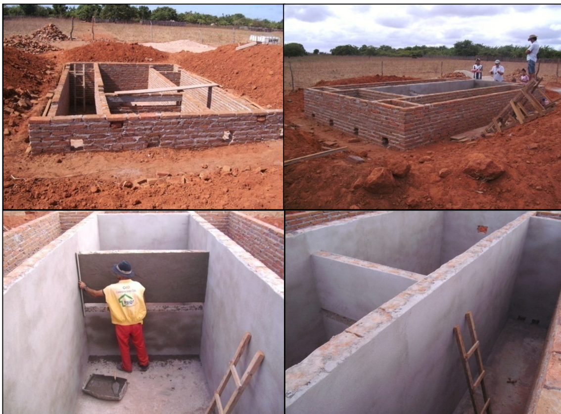
Figura 14 – Diferentes etapas na construção da ETE.
