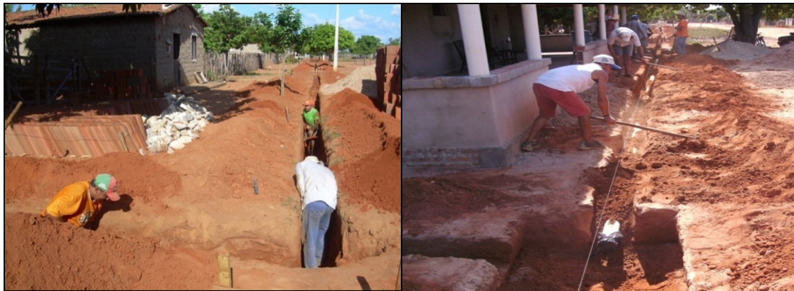
Figura 12 – Escavação das valetas e disposição dos tubos adutores de esgoto. Fonte: Arquivo próprio (2009).
