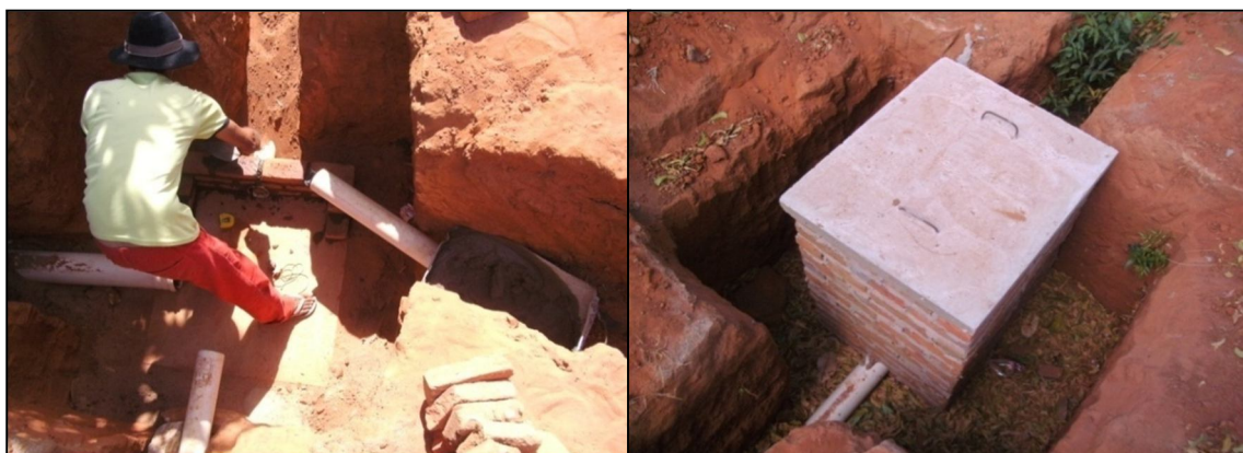
Figura 13 – Sistema de inspeção das tubulações adutora de esgoto. Fonte: Arquivo próprio (2009).
