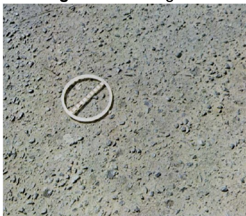
Figura 06 – Desgaste.
