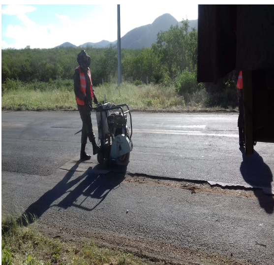
Imagem 07: Corte das regiões fragilizadas.
