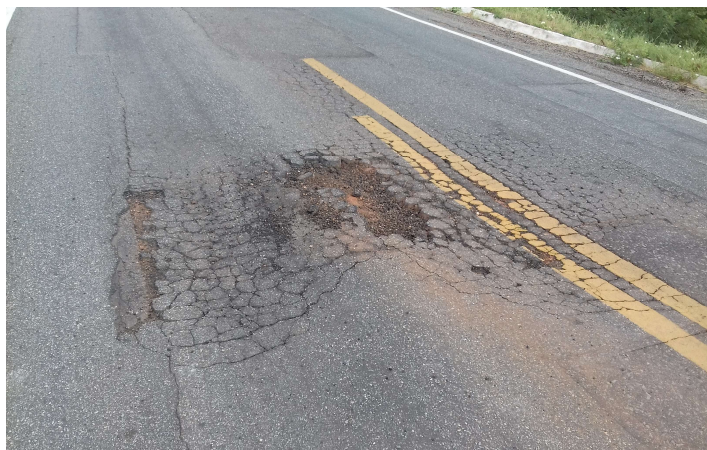
Imagem 02: Afudamento, plástico da trilha de roda.
