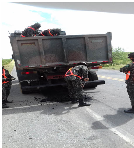
Imagem 11: Descarga do PMF (a), compactação com rolo vibrador liso (b).
