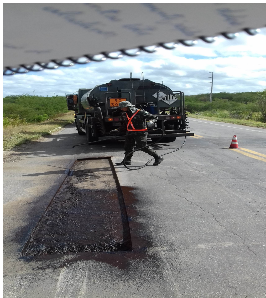
Imagem 10: Aplicação da pintura de ligação Ruptura rápida.
