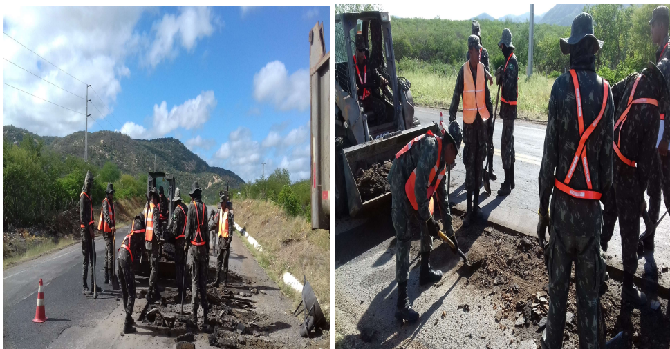
Imagem 08: Remoção do entulho gerado com o corte.
