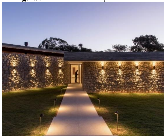
Figura 9 - Revestimento de pedras naturais
