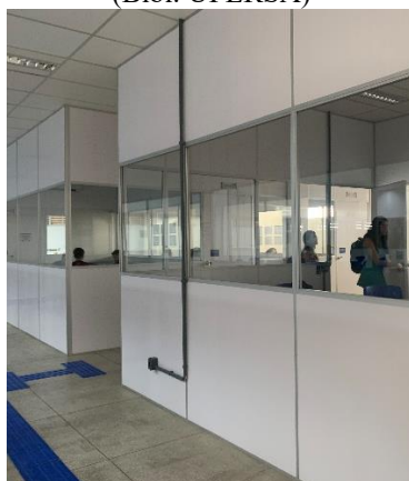
Figura 59 – Cabines Coletivas (Bibl. UFERSA)
