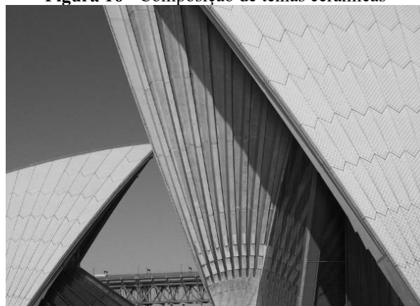
Figura 16 - Composição de telhas cerâmicas
