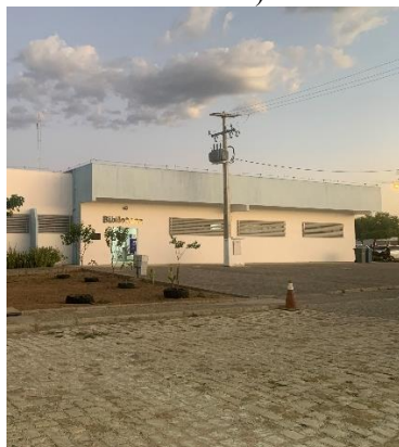
Figura 56 – Acesso (Bibl. UFERSA)
