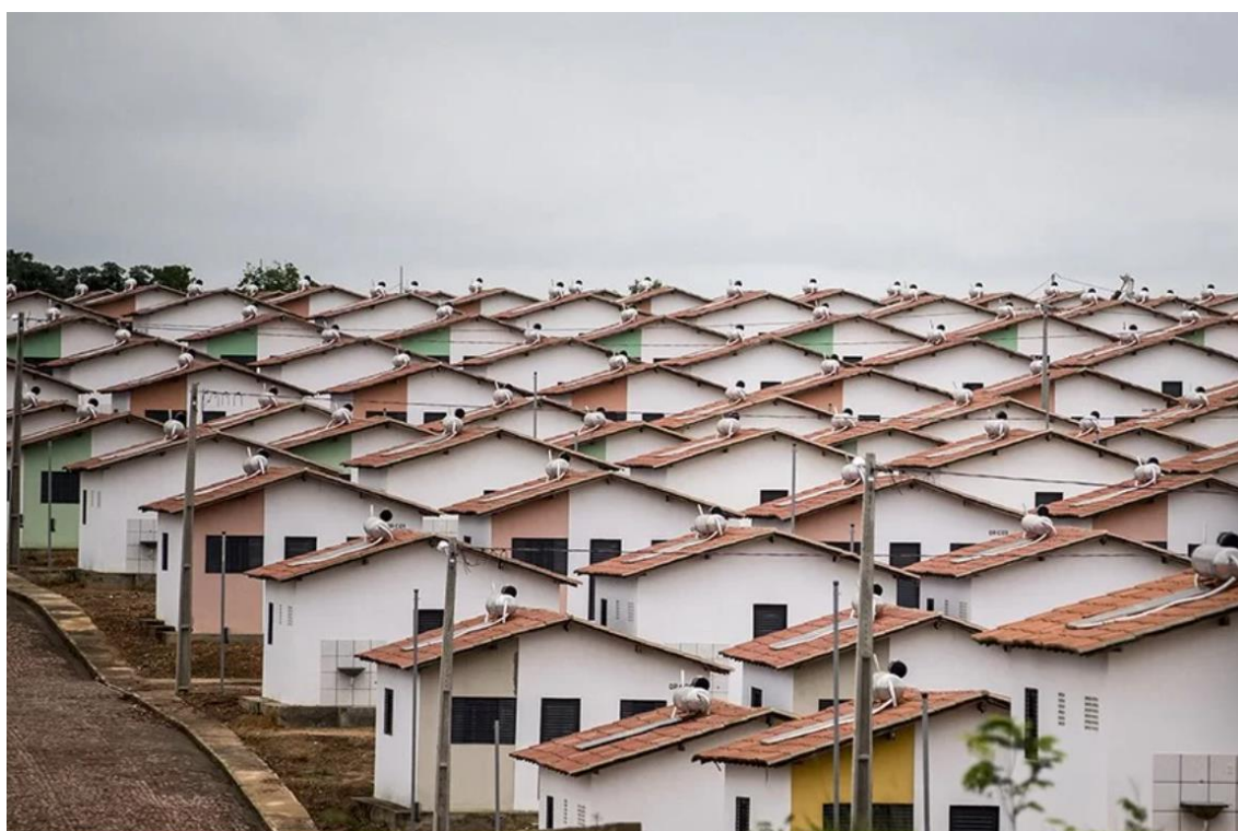
Figura 5 - Casas construídas com auxílio do PMCMV (2016).
