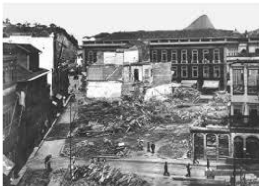
Figura 3 - Cortiço sendo demolido.
