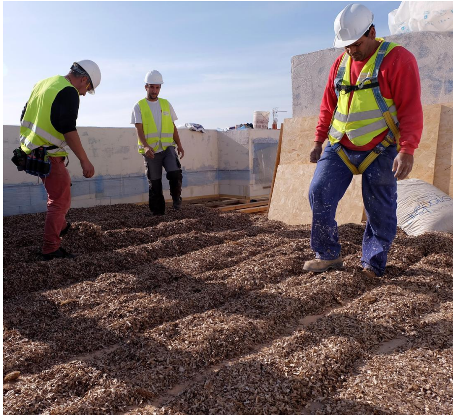
Figura 15 - Aplicação das placas de posidonia seca.
