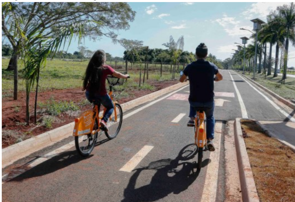
Figura 02 – Ciclovía separada fisicamente com meio fios e canteiros.
