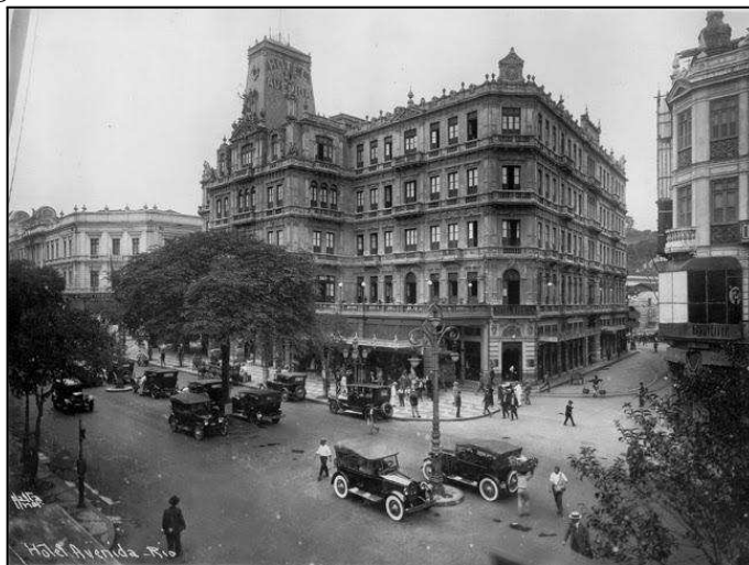
Figura 7: Foto externa do Hotel Avenida no Rio de Janeiro.
