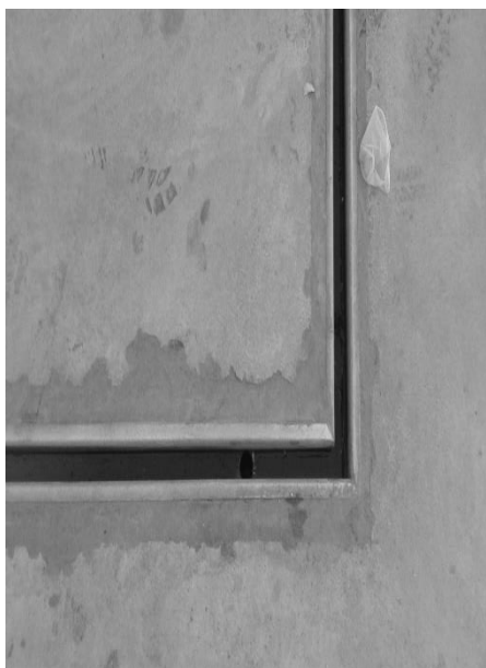
Figura 9 – Canaleta de drenagem
