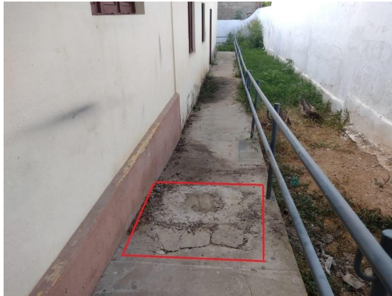
Figura 13 – Caixa de inspeção
