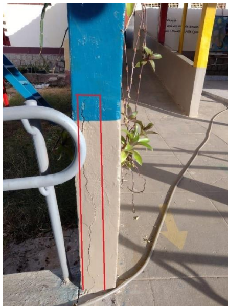
Figura 14 – Pilar de sustentação de Cobertura
