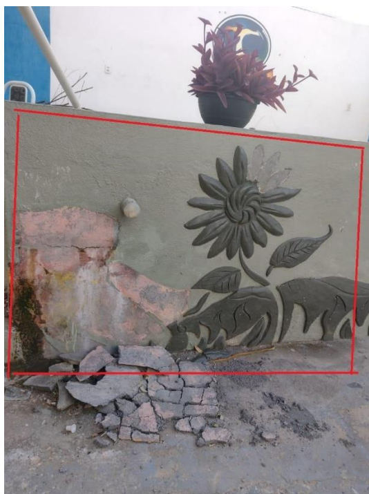
Figura 16 – Revestimento da Cisterna
