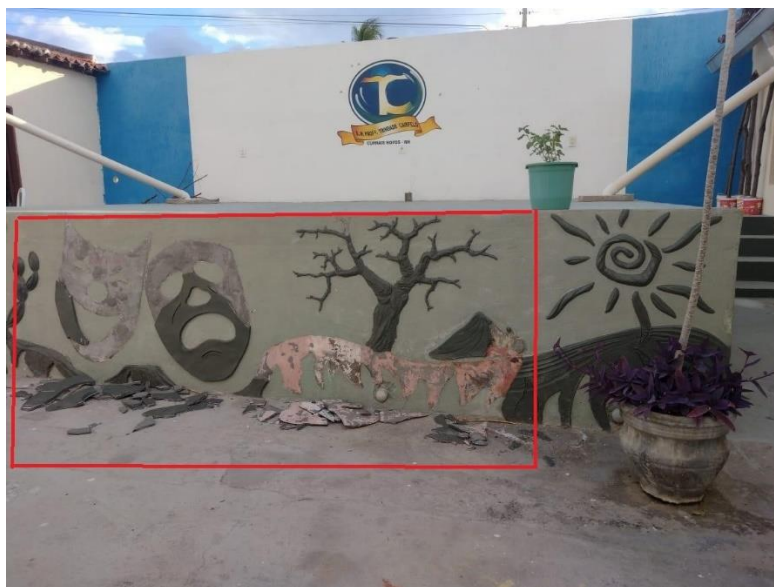
Figura 15 – Revestimento da Cisterna
