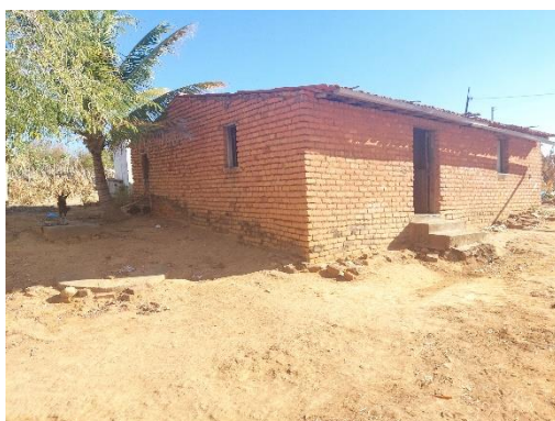
Vista da fachada frontal e lateral esquerda
