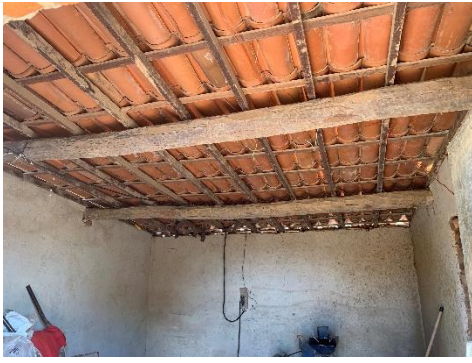
Estrutura do telhado
