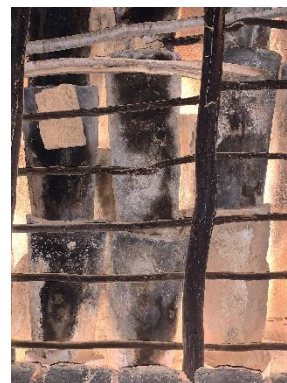
Estrutura do telhado
