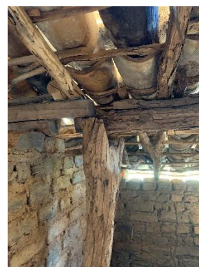
Forquilha do telhado
