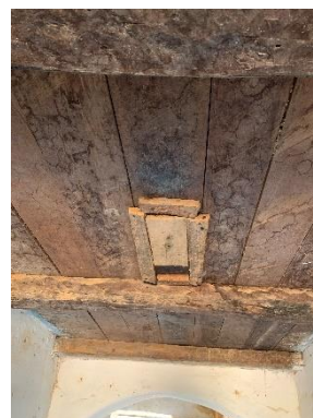
Abertura inferior do caixão
