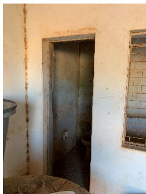
Porta do banheiro 01
