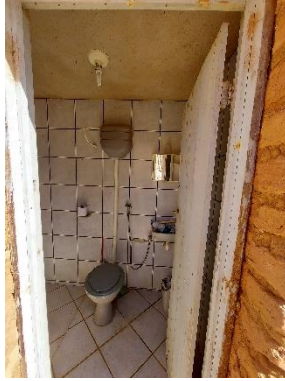
Vista interna banheiro
