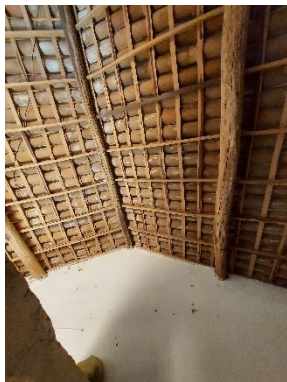
Estrutura do telhado
