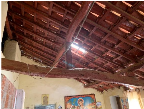
Estrutura original do telhado
