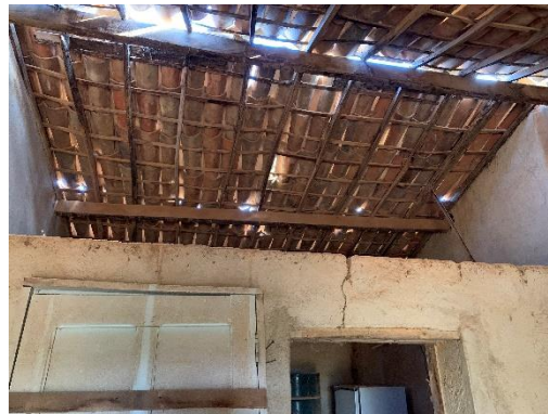
Estrutura do telhado
