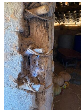
Estrutura da alvenaria
