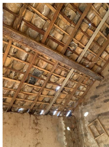
Estrutura do telhado
