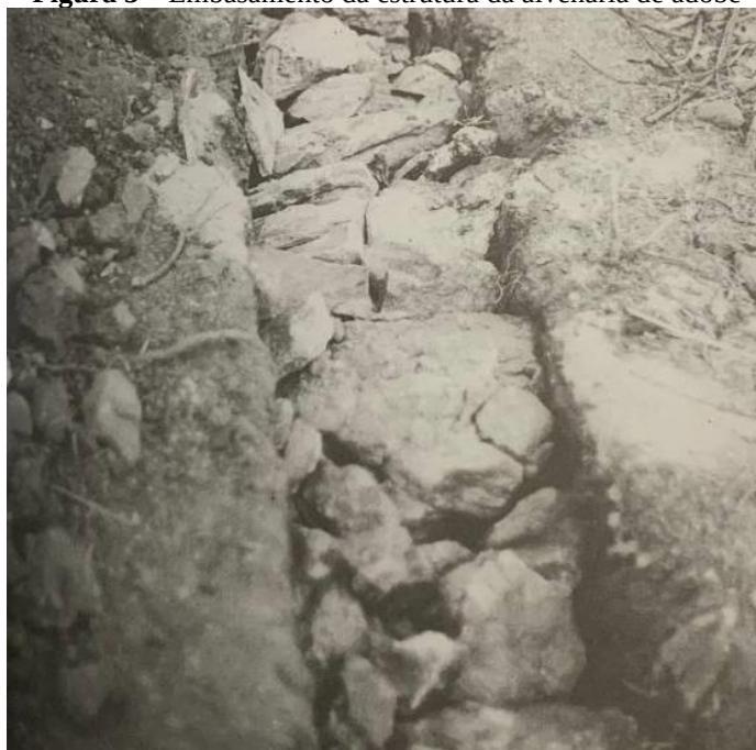
Figura 3 – Embasamento da estrutura da alvenaria de adobe
