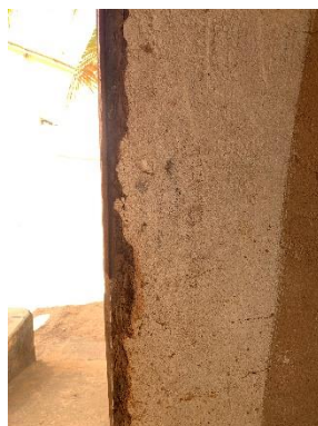
Reboco em barro branco
