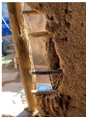
Estrutura da parede
