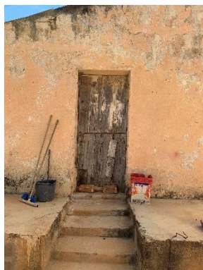
Entrada do depósito 01
