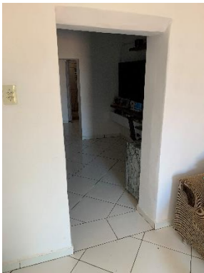
Acesso ao quarto do sótão
