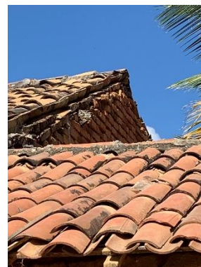
Detalhe da cumeeira e telhado
