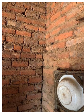
Junção das alvenarias
