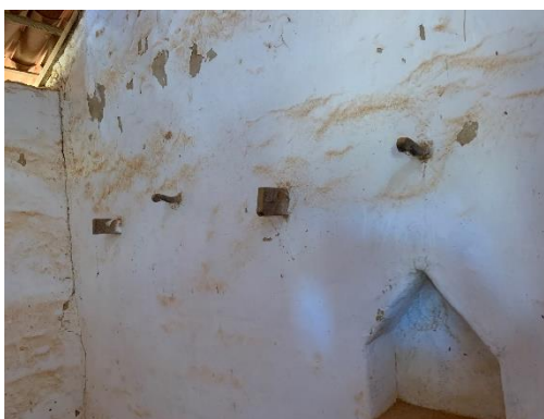
Reboco em barro branco
