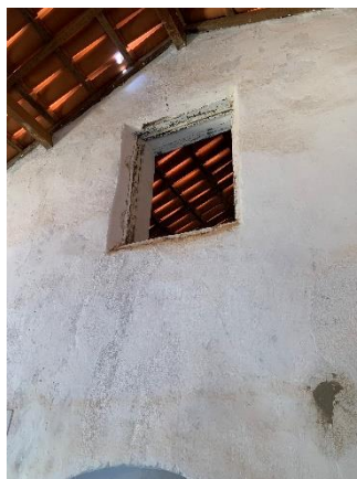
Acesso ao caixão que existia
