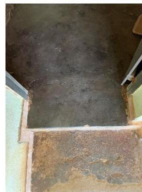
Piso cimentício verde
