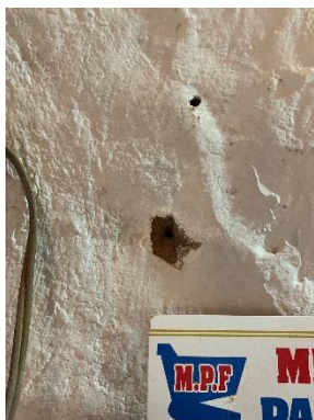
Reboco em barro branco
