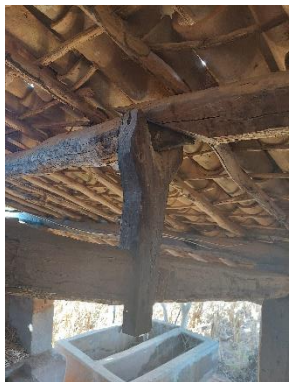
Estrutura do telhado
