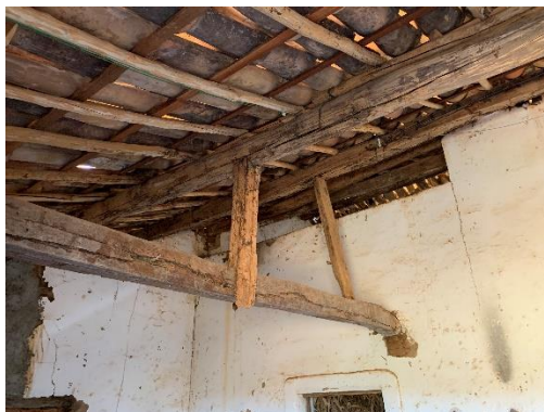
Tesoura do telhado
