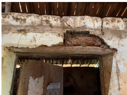
Estrutura das vergas das portas em madeira natural
