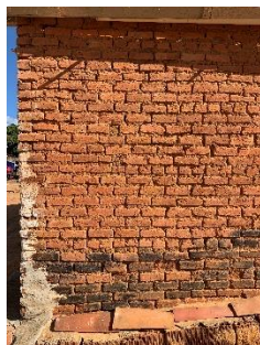
Parede em adobe e tijolo cozido
