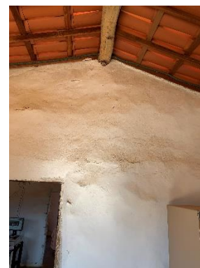
Detalhe da cumeeira e telhado
