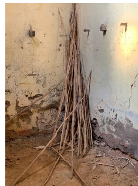
Varas retiradas do telhado
