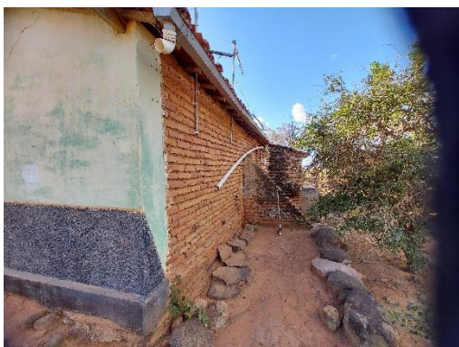
Alvenaria sem reboco
