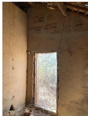
Acesso ao depósito 02
