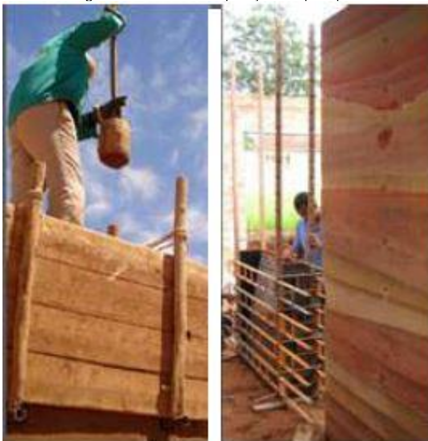
Figura 6 – Processo de compactação da taipa de pilão
