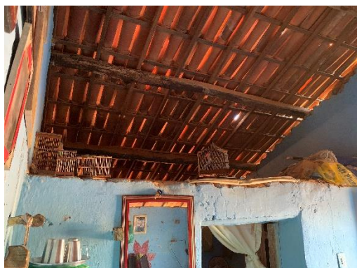
Estrutura mista do telhado vista da sala
