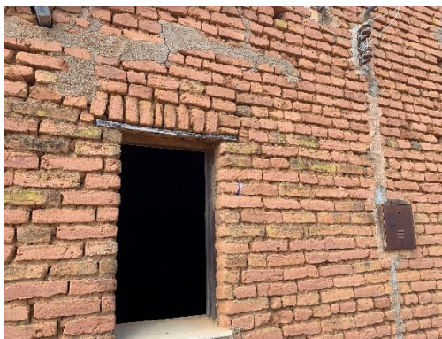
Verga da janela
