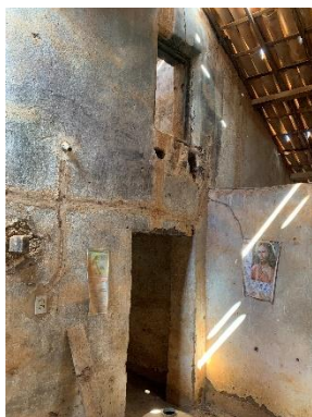
Marcas de estrutura de acesso ao caixão
