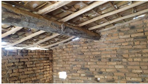
Estrutura do telhado
