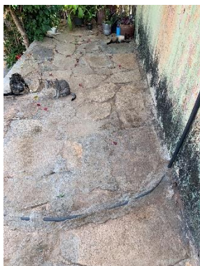
Embasamento em pedra
