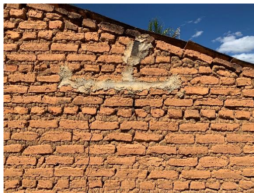
Reparo estrutural feito
