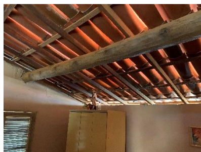
Estrutura do antigo telhado em carnaúba
