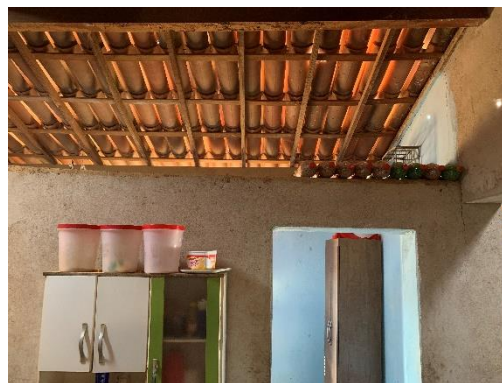
Meia parede da cozinha
