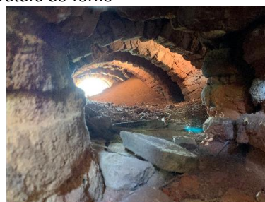
Arcos da fornalha
