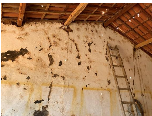
Estrutura do telhado
