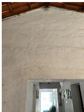
Reboco em barro branco
