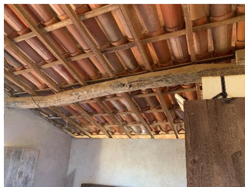
Quarto 01 – Estrutura do telhado
