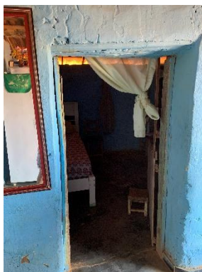
Porta de acesso ao quarto 01
