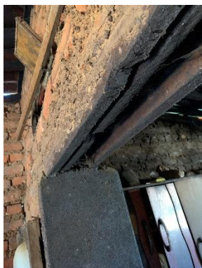
Estrutura das vergas
