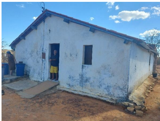
Fachada frontal e lateral direita
