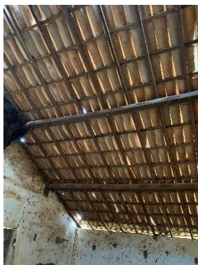
Estrutura do telhado
