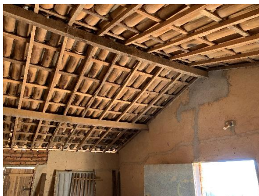
Estrutura do telhado
