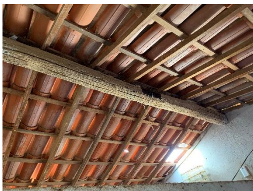
Estrutura mista do telhado
