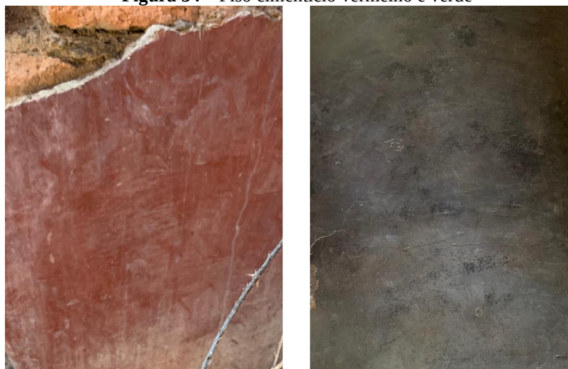
Piso cimentício vermelho
