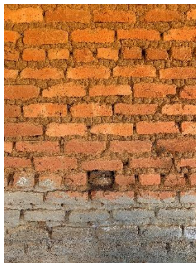
Alvenaria com chapisco
