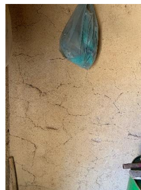
Reboco em barro branco
