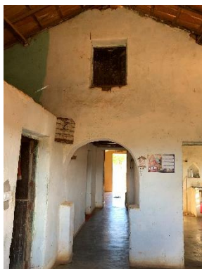
Corredor e acesso ao caixão
