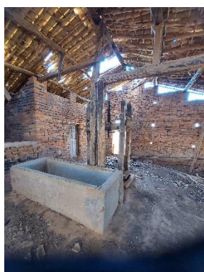
Estrutura do telhado
