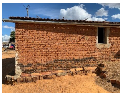
Vista da fachada lateral direita
