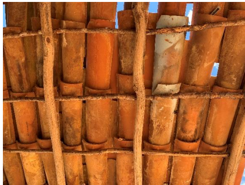
Estrutura do telhado
