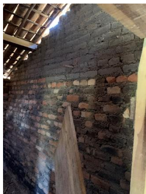
Parede mista de tijolo cozido e adobe
