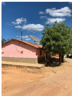
Fachada lateral esquerda
