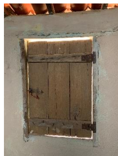
Janela em ficha existente
