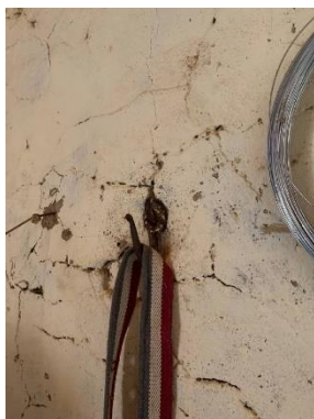
Armador de ferro quarto 02
