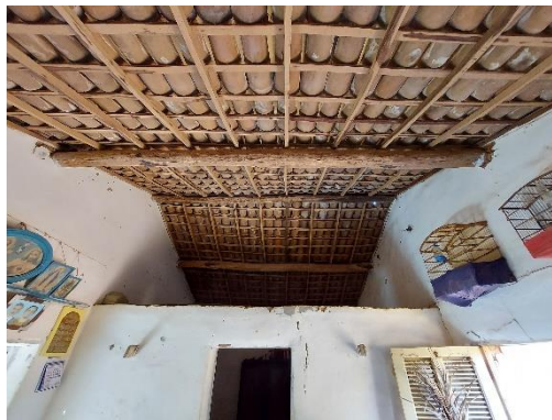
Estrutura do telhado
