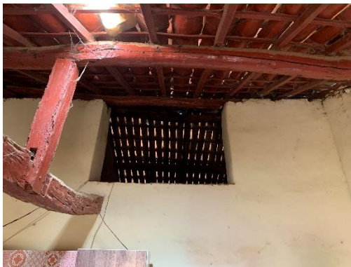
Vão aberto na cozinha
