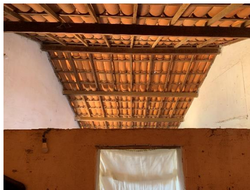
Estrutura do telhado
