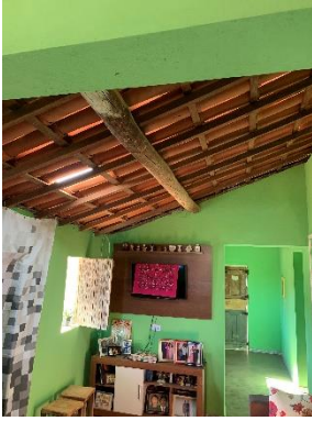
Estrutura mista do telhado
