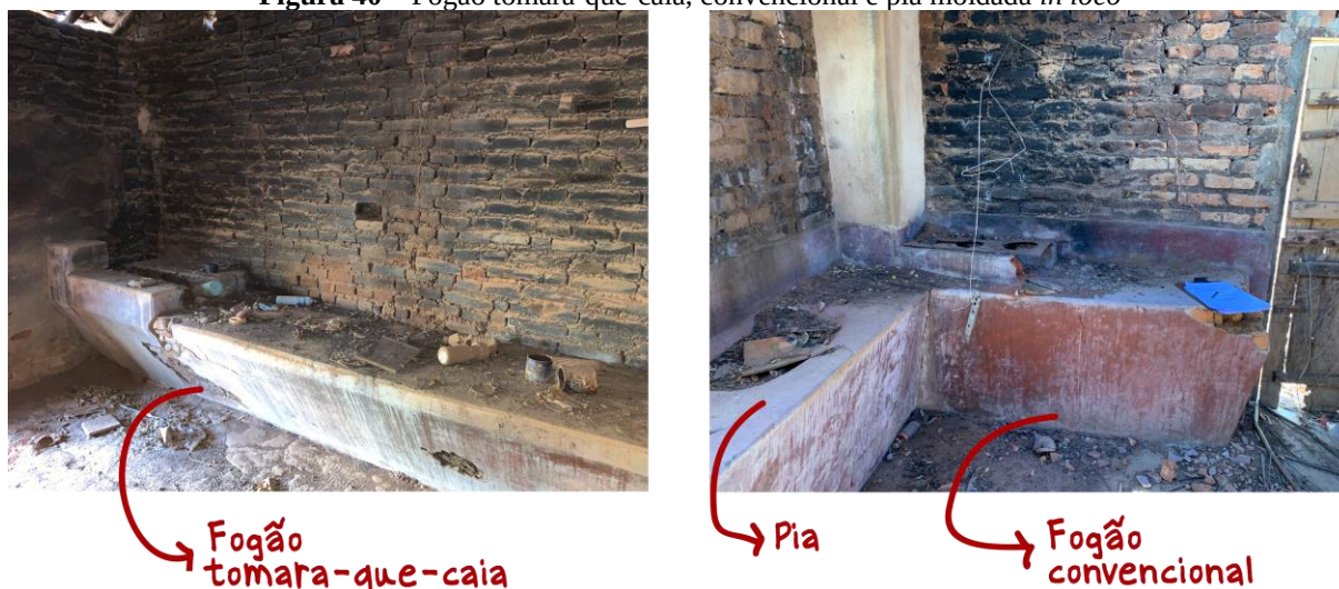
Figura 40 – Fogão tomara-que-caia, convencional e pia moldada in loco
