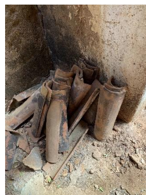
Telhas retiradas da cobertura em ruína
