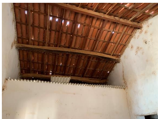
Estrutura do telhado
