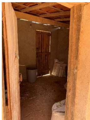
Porta de acesso fachada posterior
