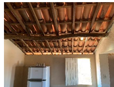
Telhado com estrutura antiga e recém posta
