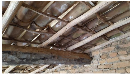
Estrutura do telhado
