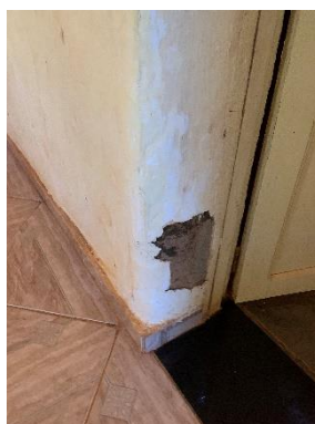
Reboco em barro branco
