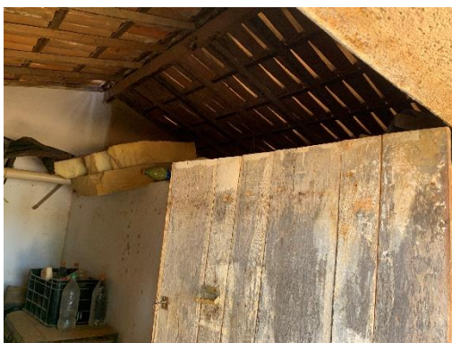
Vista do depósito 01
