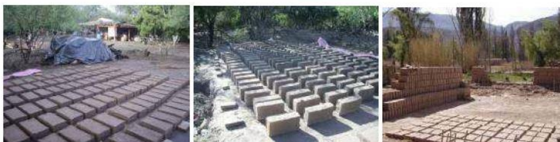
Figura 2 – Secagem dos blocos de adobe
