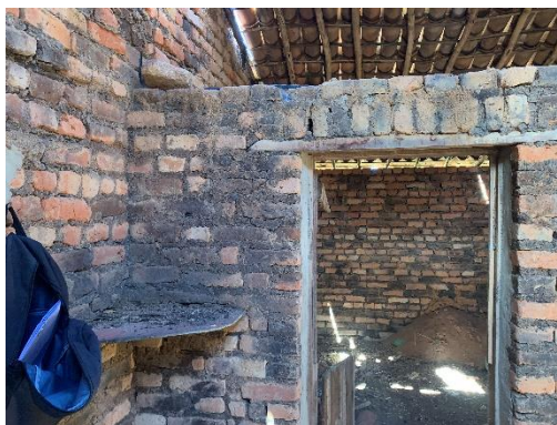
Estrutura das aberturas
