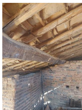
Estrutura do telhado
