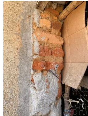
Entrada do depósito 01
