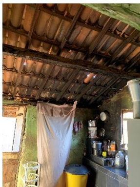
Estrutura mista do telhado vista da cozinha
