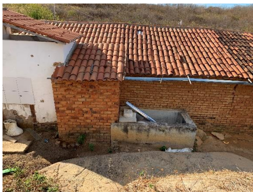
Fachada lateral esquerda
