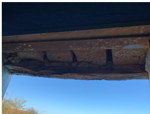
Estrutura das aberturas
