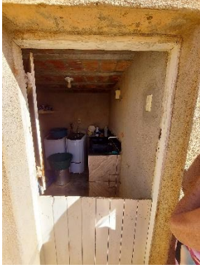
Acesso ao depósito
