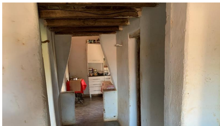
Abertura de acesso à sala de jantar
