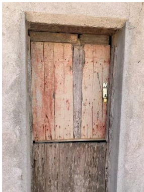
Entrada do depósito 02
