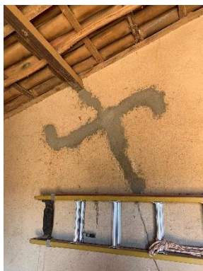
Reforço estrutural realizado
