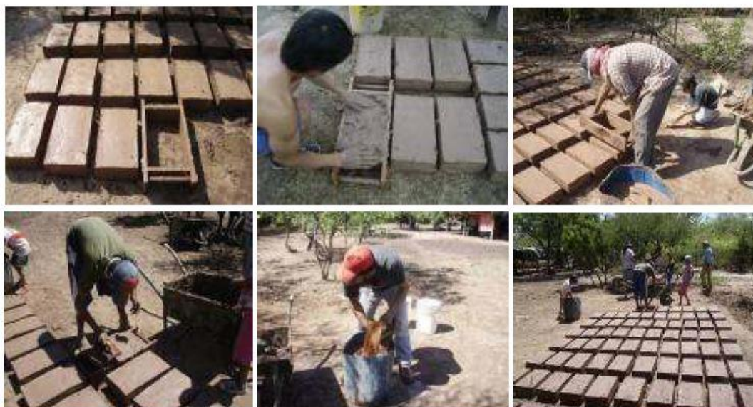
Figura 1 - Moldagem dos blocos de adobe
