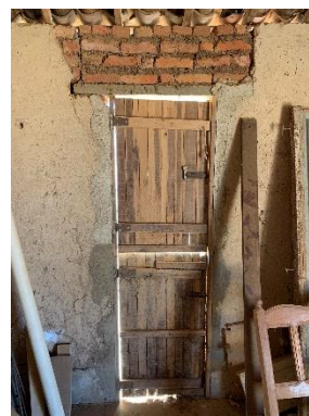
Verga em concreto inserida posteriormente
