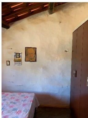
Reboco em barro branco
