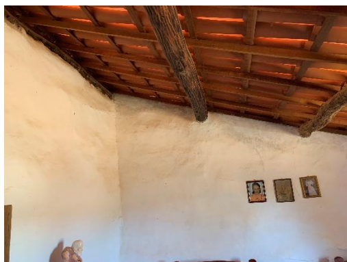
Estrutura em madeira natural do telhado
