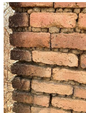
Tijolo maciço queimado usado nas paredes externas
