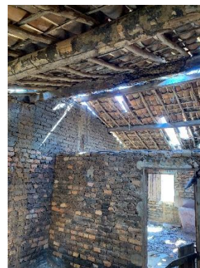
Estrutura do telhado
