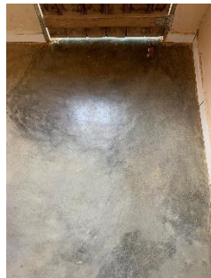
Piso em cimento verde
