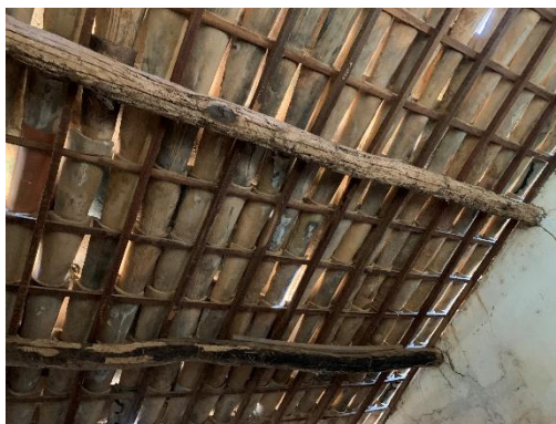
Estrutura do telhado
