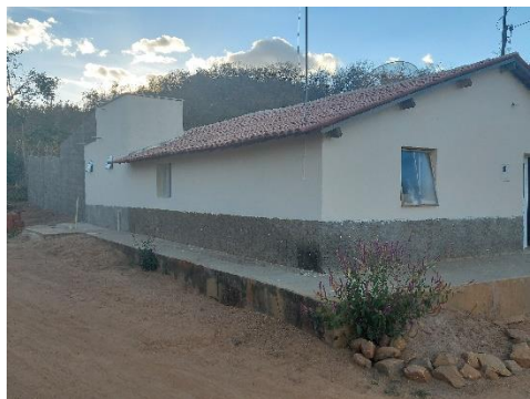
Vista da fachada lateral esquerda e frontal
