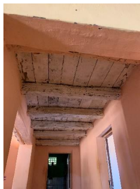
Estrutura do caixaão
