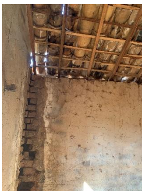
Estrutura do telhado
