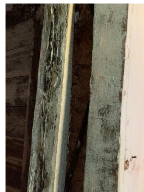
Verga das esquadrias
