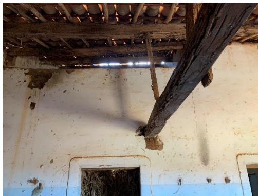
Estrutura do telhado
