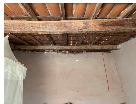
Terça em madeira natural no telhado
