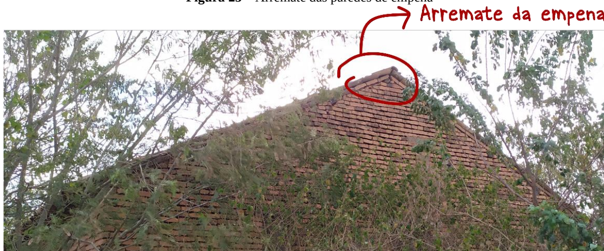
Figura 25 – Arremate das paredes de empena
