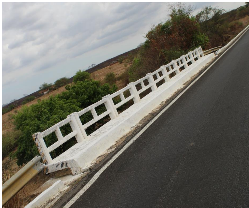
Figura 17 - Guarda-corpo e guarda-rodas.
