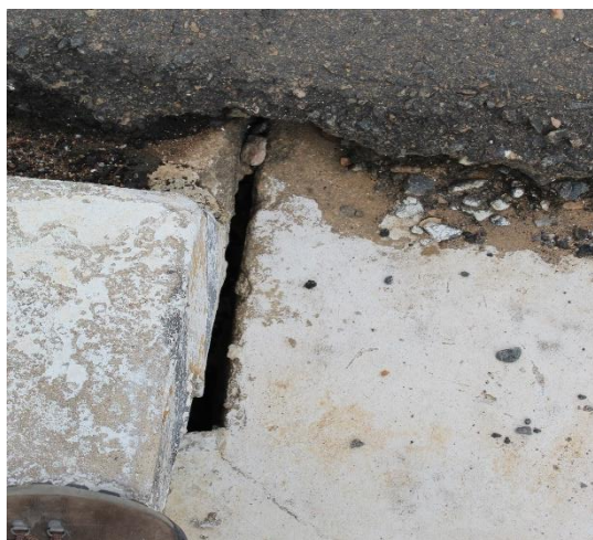
(b) junta de dilatação
