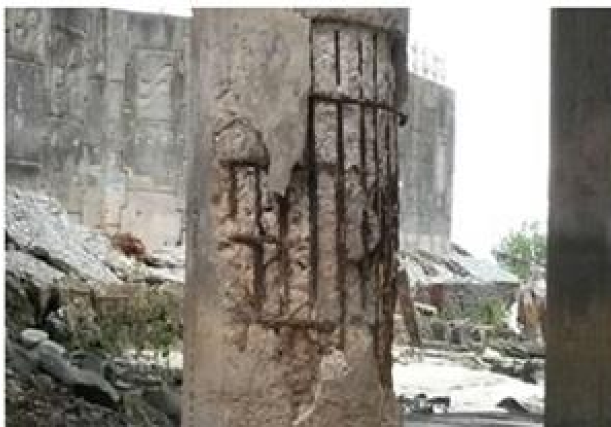
Figura 3 - Ponte sobre o rio calhau na avenida litorânea em São Luís-MA
