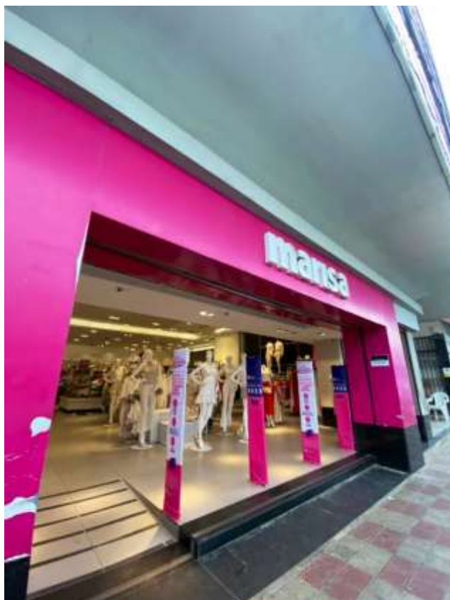
Figura 68 - Fachada do antigo Cine Pax, atualmente ocupada por estabelecimento comercial, Mossoró (2026)
