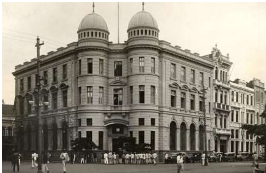
Figura 45 - Edifício do antigo Bank of London & South em Recife (PE), inaugurado em 1912
