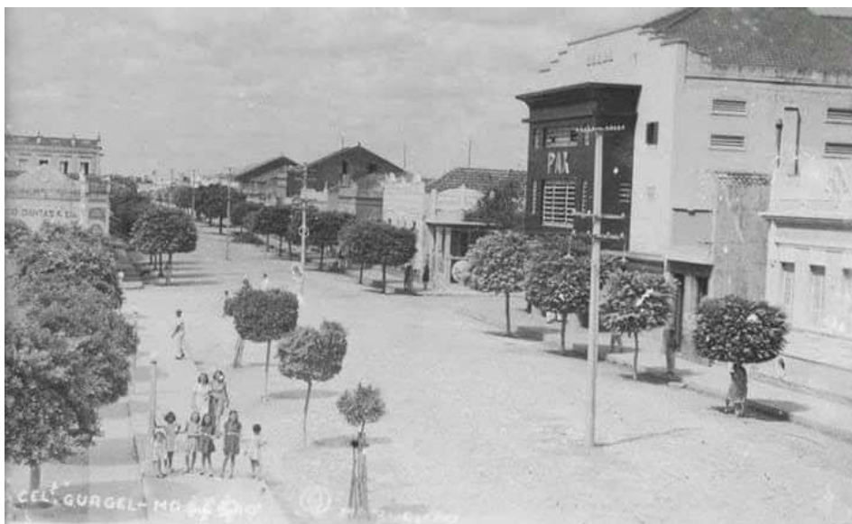
Figura 24 - Vista da Rua Coronel Gurgel com destaque para o Cine Pax, Mossoró, década de 1940
