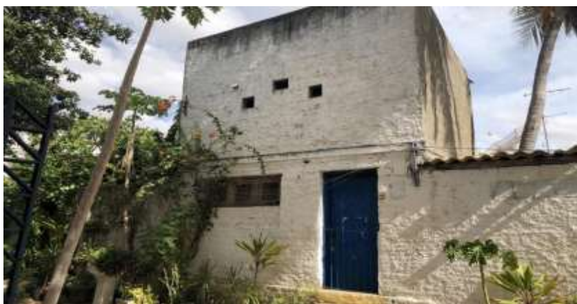
Figura 30 - Estrutura remanescente do Cine Imperial, Mossoró (RN), evidenciando possível antiga cabine de projeção
