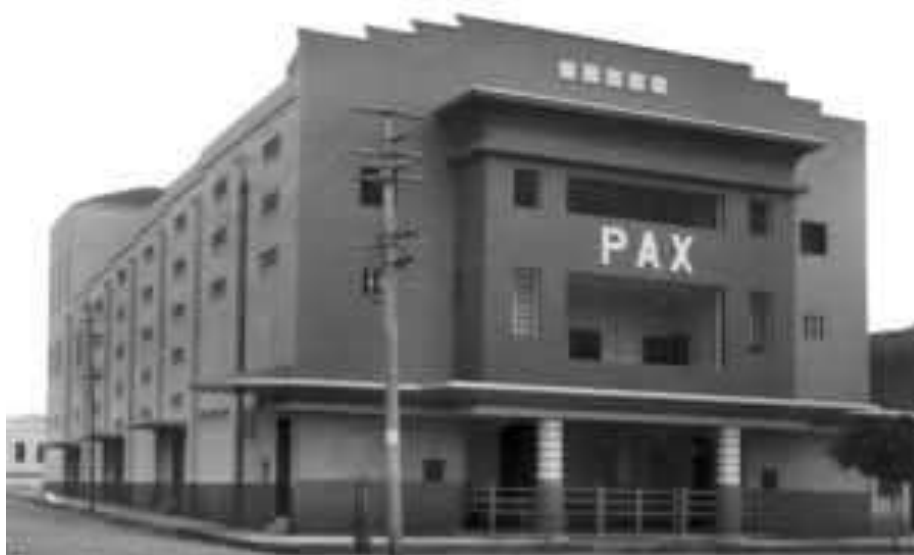
Figura 50 - Fachada do Cine Pax, evidenciando sua composição volumétrica e elementos arquitetônicos (s.d)
