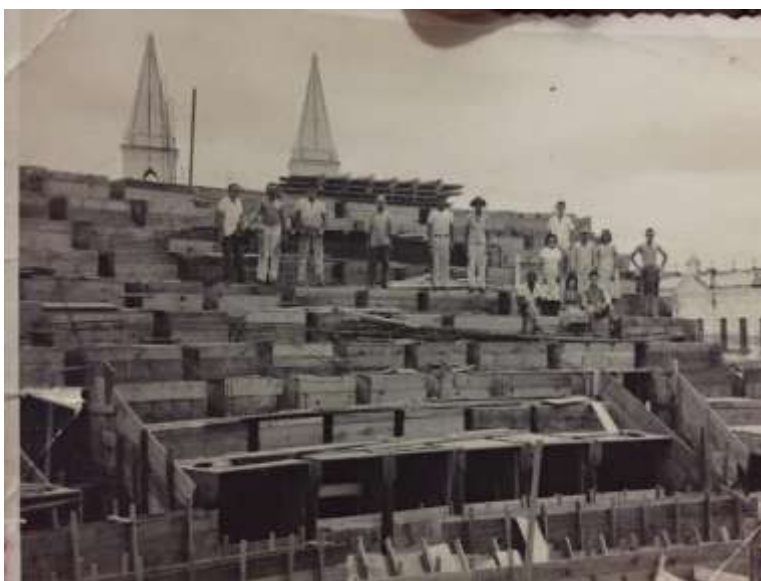
Figura 33 - Construção da parte interna do Cine Cid, 1963.
