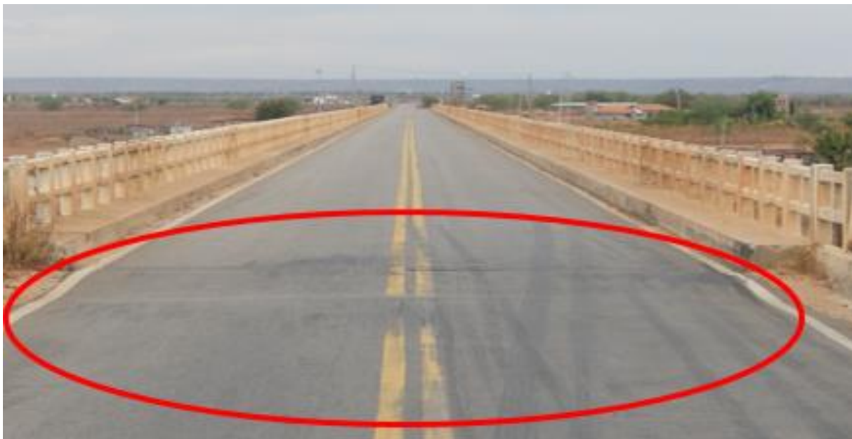
Figura 35 - Acesso da ponte
