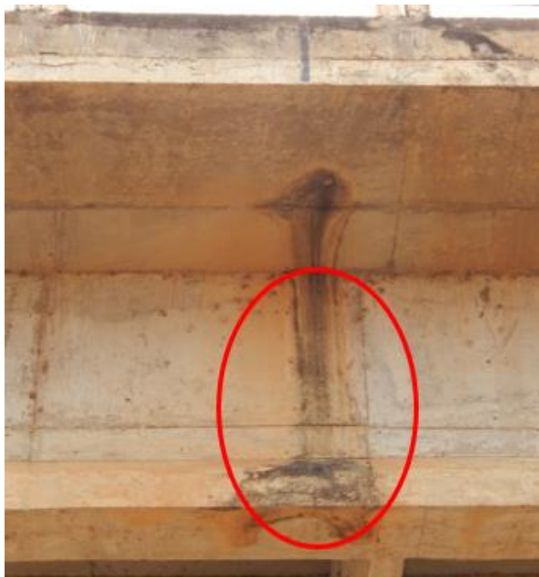
a) Manchas de umidade na face lateral da viga
