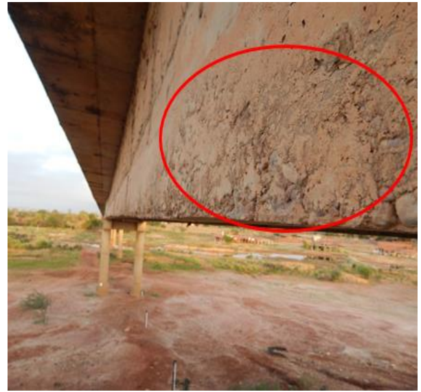
b) Ninhos de concretagem
