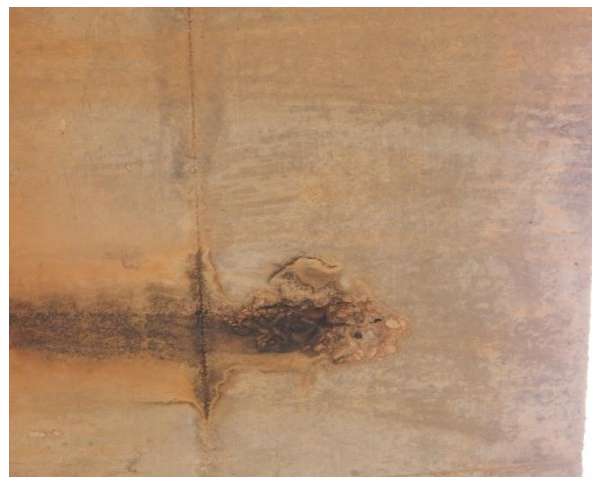
b) Desagregação ao redor dos buzinos
