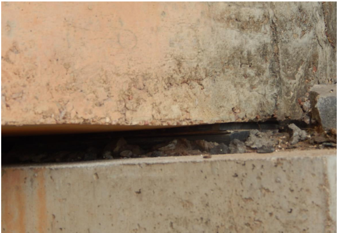
Figura 25 - Aparelho de apoio
