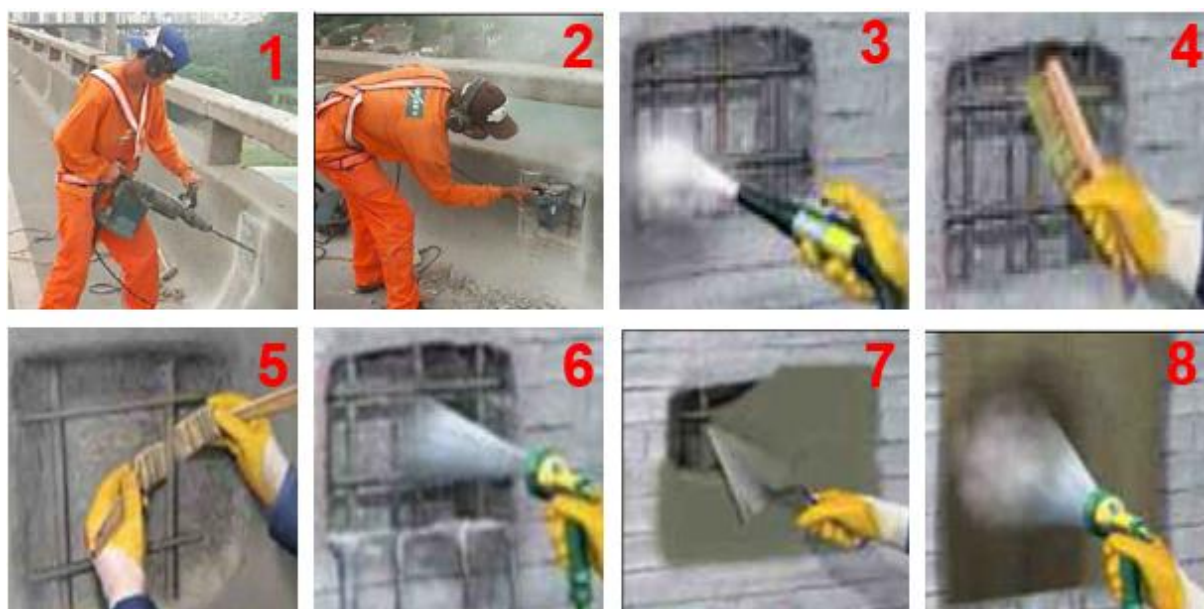
Figura 38 - Processo de tratamento de corrosão da armadura
