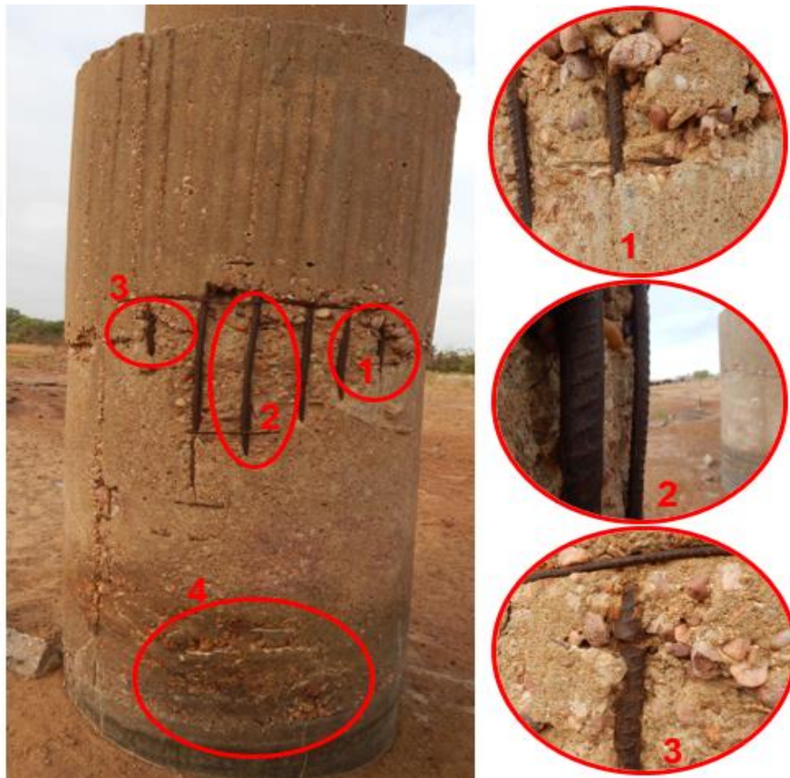
Figura 29 - Manifestações visualizadas no bloco 10 (Direita)
