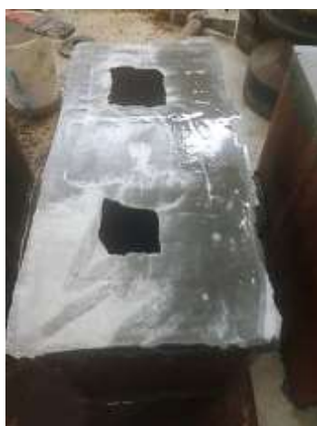
Figura 25 – Capeamento do Bloco para regularização das faces.
