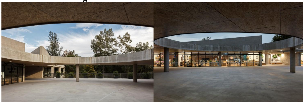
Figura 32 - Abertura circular - Escola Beelieve.
