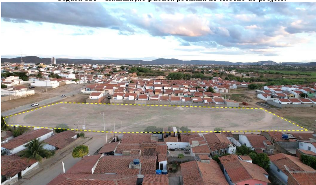
Figura 128 – Iluminação pública próxima ao terreno de projeto.
