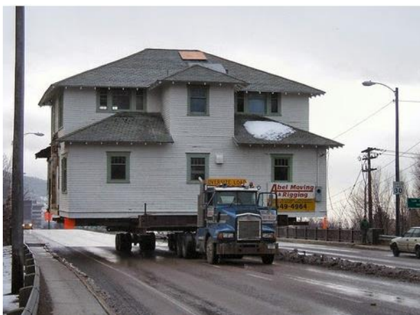
Figura 3: Casa de madeira sendo transportada nos EUA.
