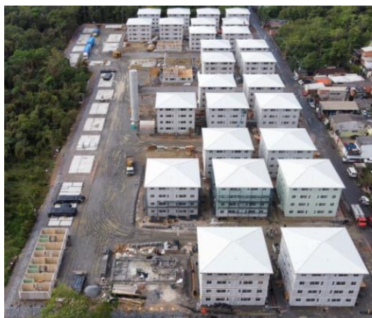
Figura 5: Construção em WF, São Paulo.
