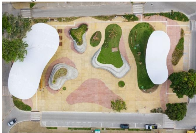
Figura 11: Acessibilidade na Praça da Saudade
