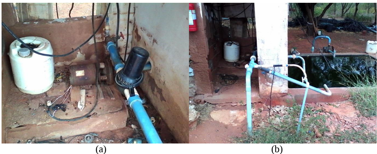
Figura 10. Sistema de bombeamento da Fazenda Experimental Rafael Fernandes: a) detalhe da motobomba e b) reservatório e conjunto de registros reguladores de vazão-pressão
