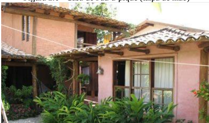
Figura 2.6 - Casa de Pau-a-pique (taipa de mão)
