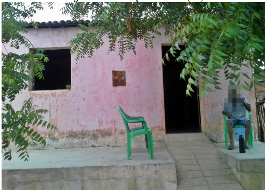
Figura 4.3 -Edificação em adobe (C3)
