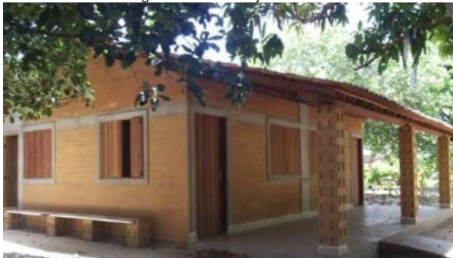
Figura 2.17 - Construção bem feita
