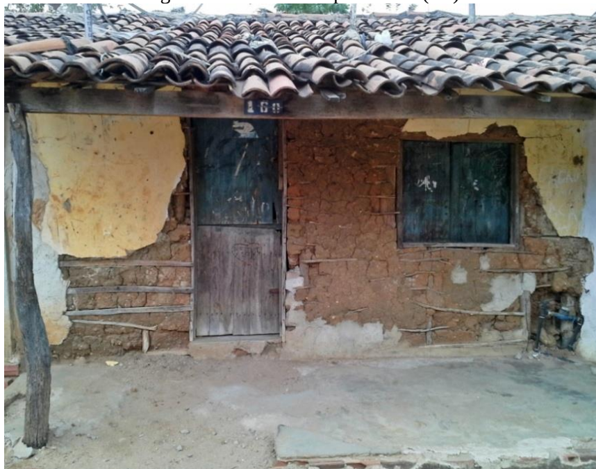
Figura 4.2 - Casa de taipa de mão (C2)
